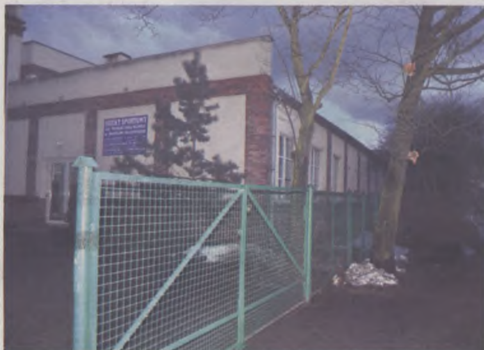
Świetlica wiejska w Bystrzycy
