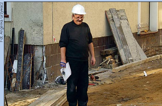
Marcin Zawila, szef biblioteki grodzkiej, na placu budowy Książnicy Karkonoskiej
