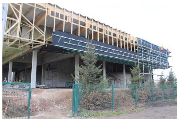
Budowa biblioteki w Czarnym Borze Fot. Arch. GBP w Czarnym Borze
