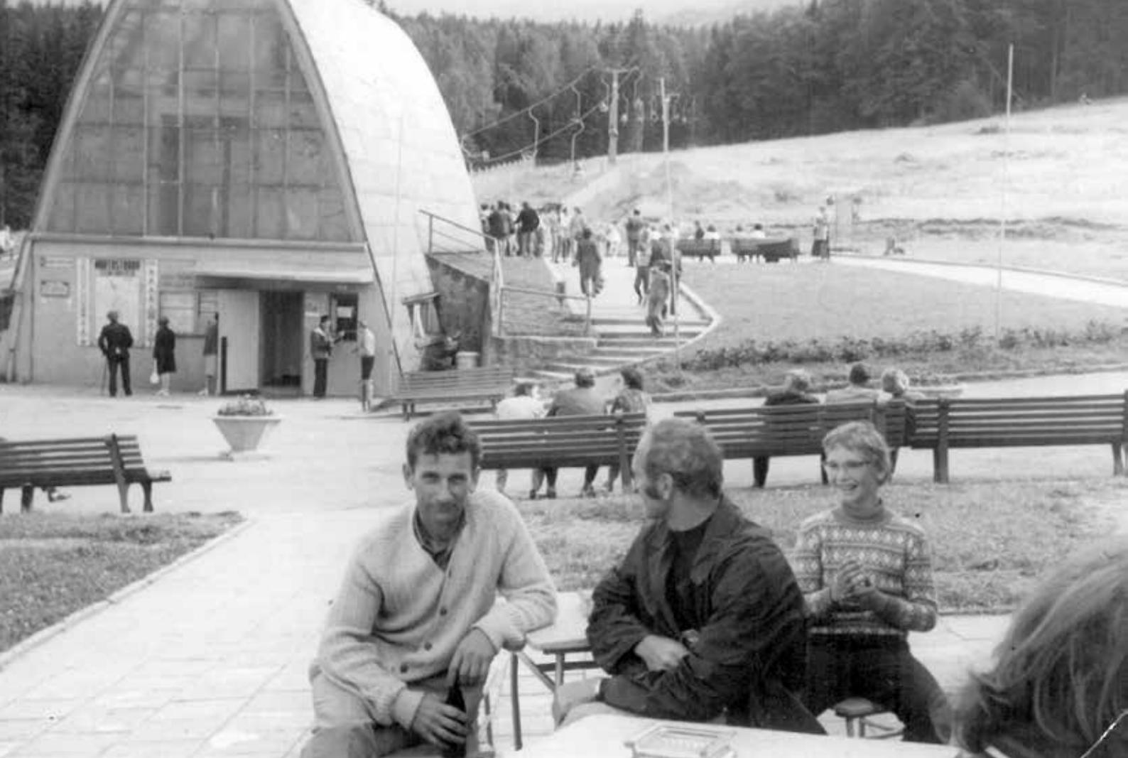
Piotr Maraszek – dolna stacja kolei linowej
