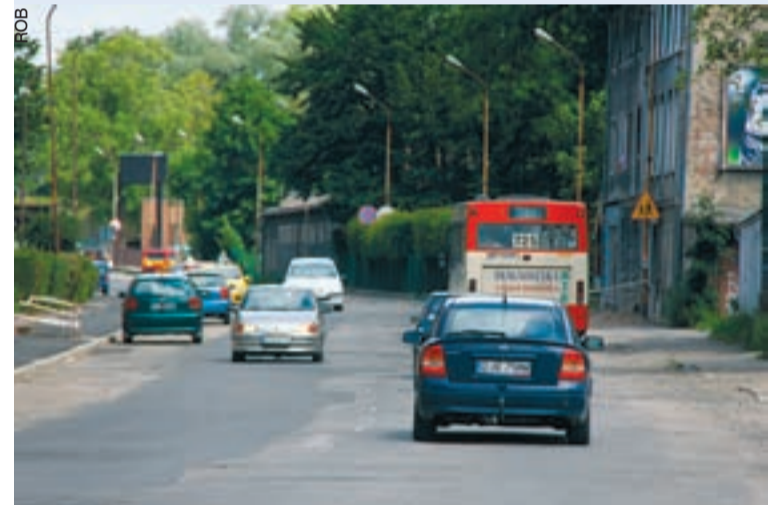
Ludzie z utęsknieniem czekają na remont ulicy Osiedle Robotnicze. Droga ma być wyremontowana do października przyszłego roku.
