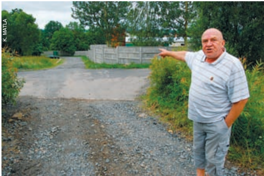
Mieczysław Bajda nie szczędzi słów krytyki pod adresem władz gminy. Doraźne działania uważa za stratę pieniędzy; tu potrzeba kompleksowego remontu.
