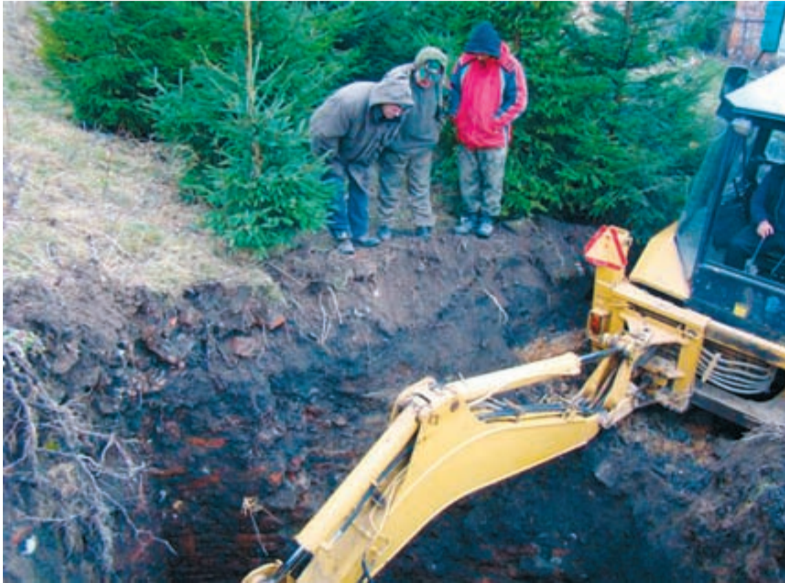
W tunelu korytarza znaleziono trzy skrzynie pełne dokumentów.
