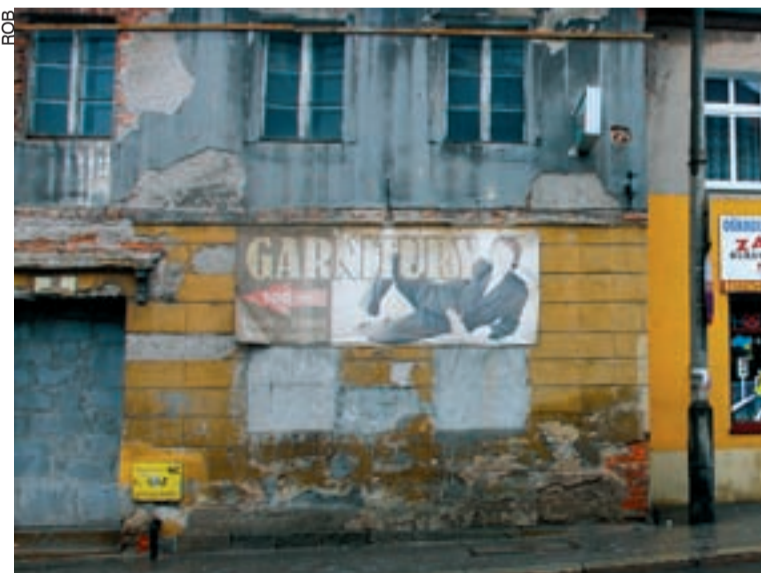
Ulica Sobieskiego: reklama wprowadzie nie pierwszej świeżości, podobnie zresztą jak elewacja kamienicy. Miejmy nadzieję, że chociaż garnitury z najwyższej półki. (rob)
