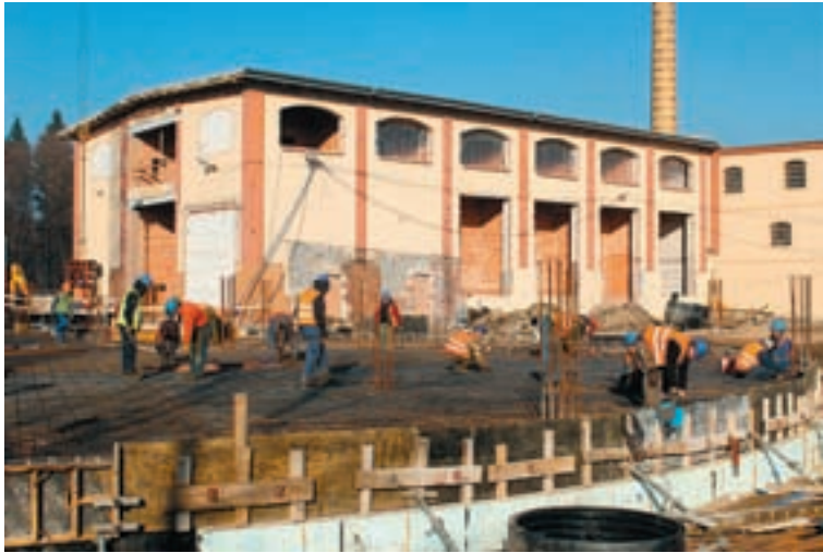
Tak dziś wygląda plac budowy. Za siedem miesięcy Termy Cieplickie mają przyjąć pierwszych gości.
