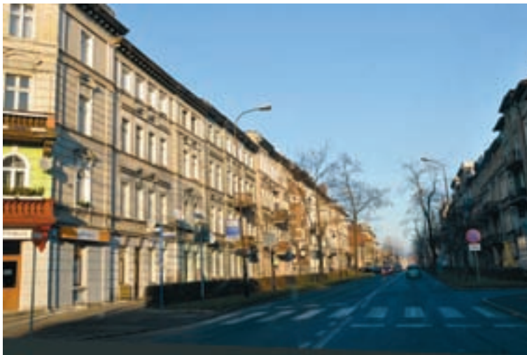
Mimo kryzysu w przyszłym roku remont może objąć 20 kamienic po obu stronach al. Wojska Polskiego w Jeleniej Górze.
