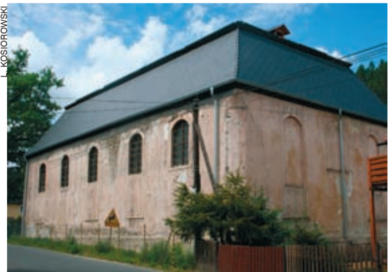
Kościół poewangelicki w Wojcieszycach ma nowy dach. W przyszłości ma być salą widowiskową.
