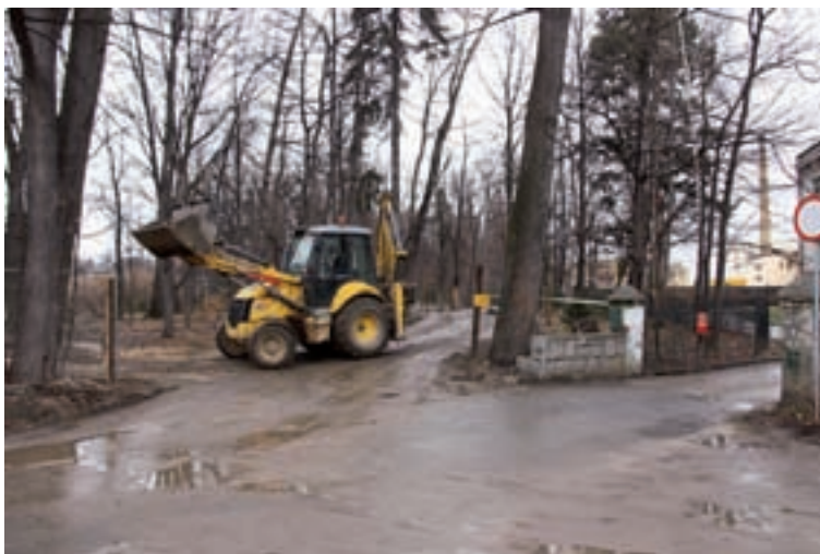
W Cieplicach trwa kilka ważnych inwestycji. Czy nowa rada będzie miała wpływ na ich przebieg?
