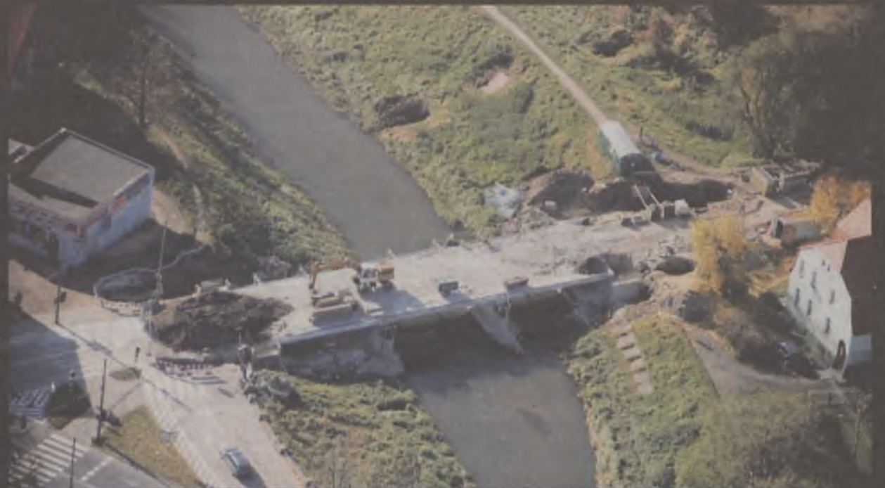
Remont mostu na Oławce - ulica Strzelna
