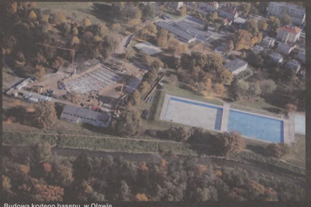
Budowa krytego basenu w Oławie
