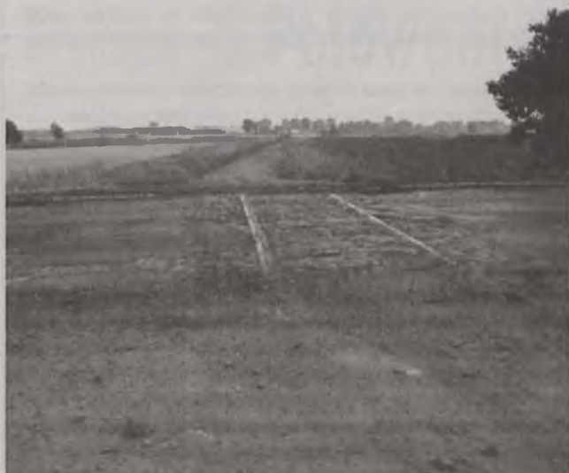
Fragment toru z linii kolejowej Oława - Boreczek, przecinający drogę w okolicach Jaczkowic
