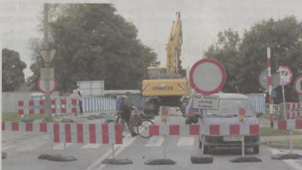
Remont mostu potrwa ponad dwa miesiące. Dla pieszych będzie zamknięty przez miesiąc
