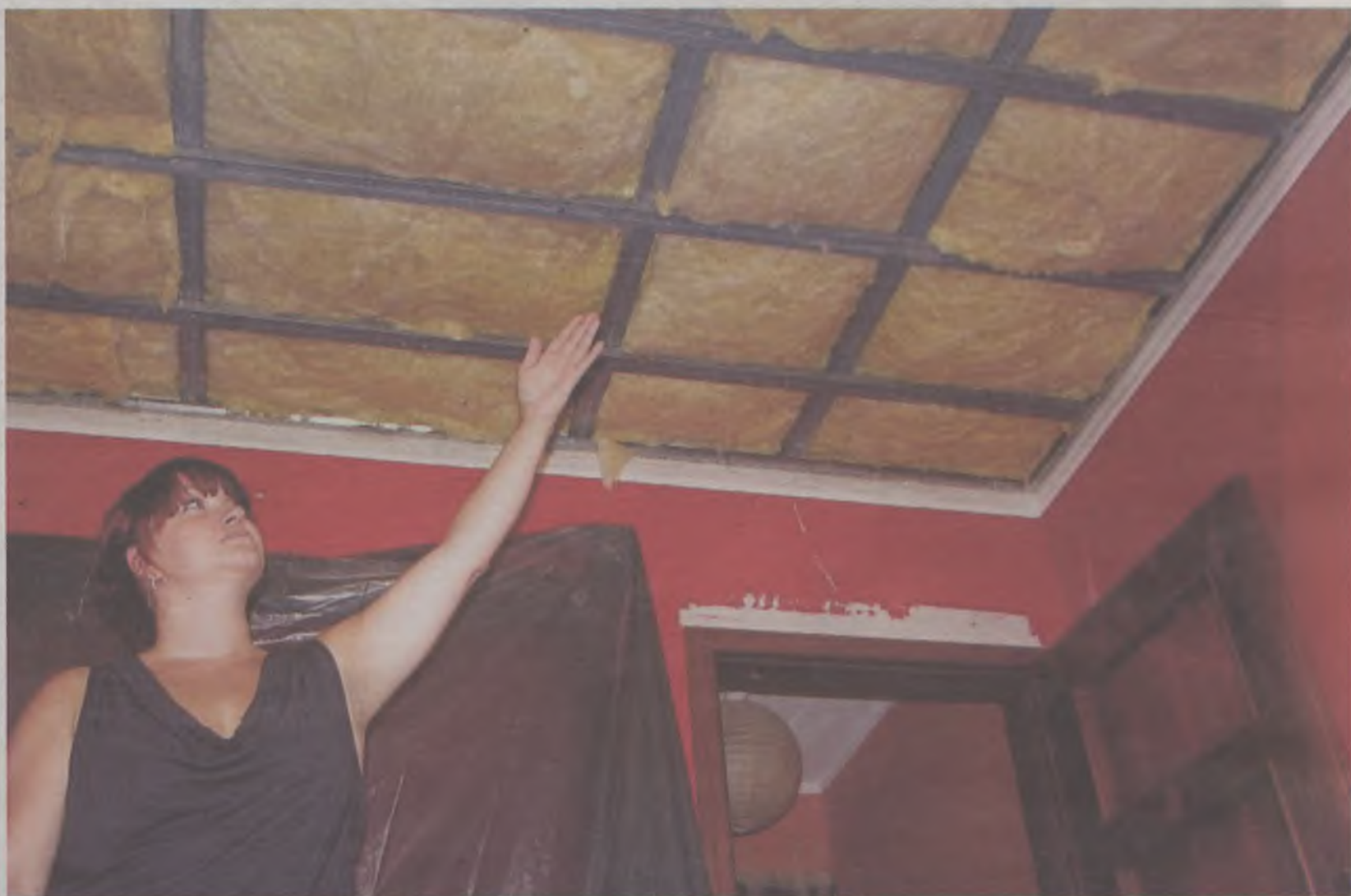
- Trzeba było pozrywać sufity i płyty kartonowo-gipsowe na skosach we wszystkich pokojach na górze, by ocieplić całość wełną mineralną - mówi pani Ilona
