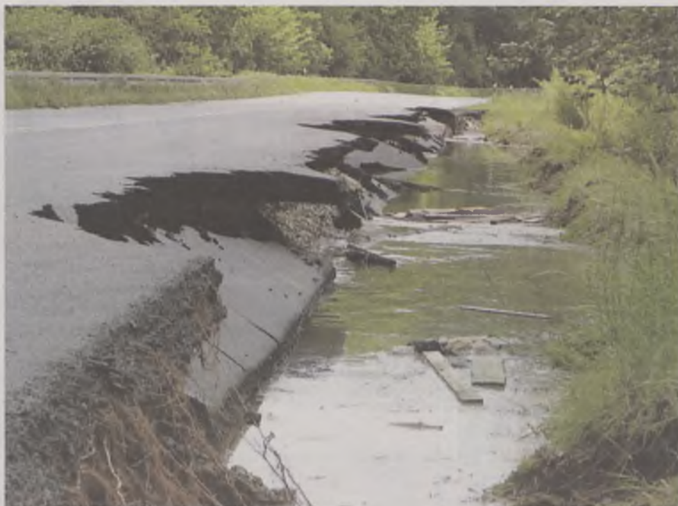
Droga wojewódzka nr 455 Oława - Jelcz-Laskowice jest zamknięta od miesiąca. W ciągu kilku najbliższych dni ma być dopuszczony ruch wahadłowy
