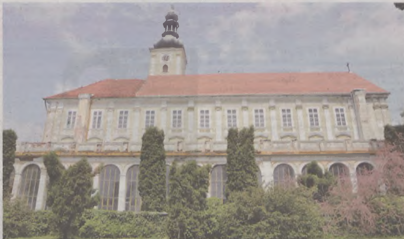
Dach kościoła św. Wawrzyńca wymagał remontu. Teraz upiększa zabytkową świątynię
