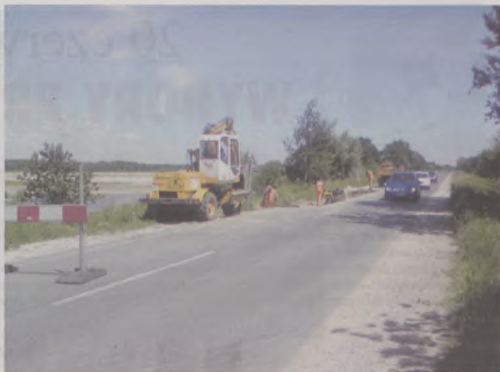
Droga Oława-Janików jest już wyremontowana
