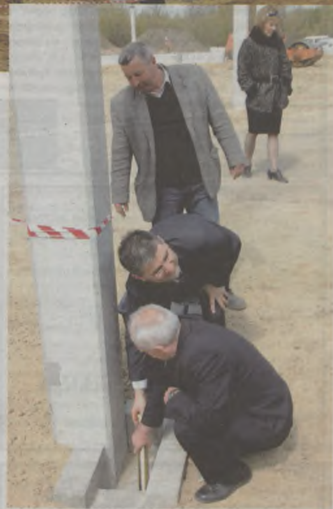
Wmurowanie tuby z aktem erekcyjnym rozpoczęli przedstawiciele inwestora i głównego wykonawcy
