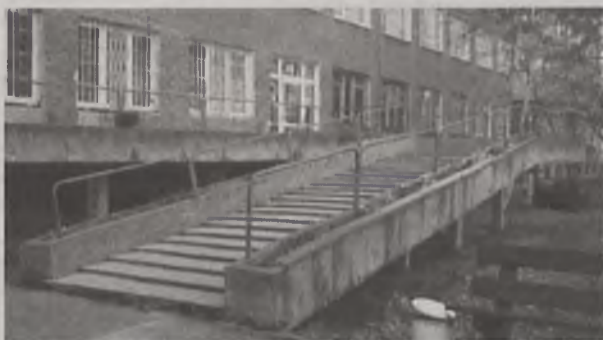
Chodniki, przejścia obok budynku, a także wejścia do szpitala zdaniem komisji nie są przystosowane do korzystania przez osoby niepełnosprawne...
