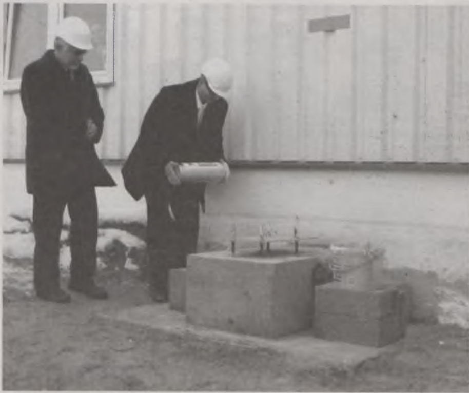
Pamiętkową tubę zabetonowano w specjalnie przygotowanym miejscu na placu budowy, a zrobili to Kazimierz Putyra i Thomas Keller
