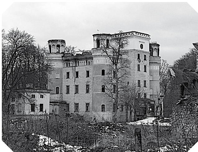
Pałac w Wojanowie przed remontem...
