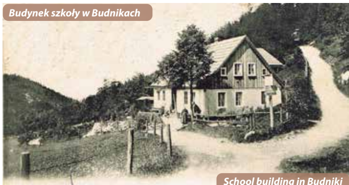
Budynek szkoły w Budnikach School building in Budniki
