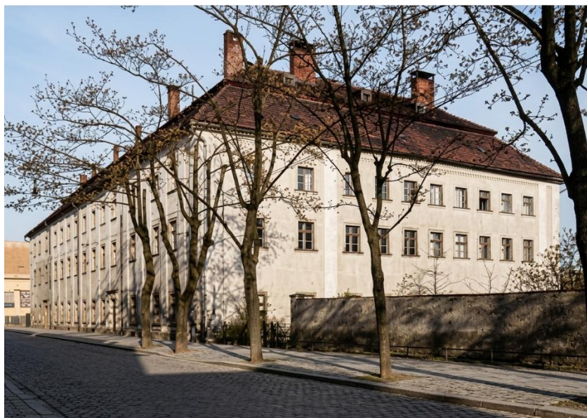
Rys. 22. Budynek szkoły ewangelickiej.
