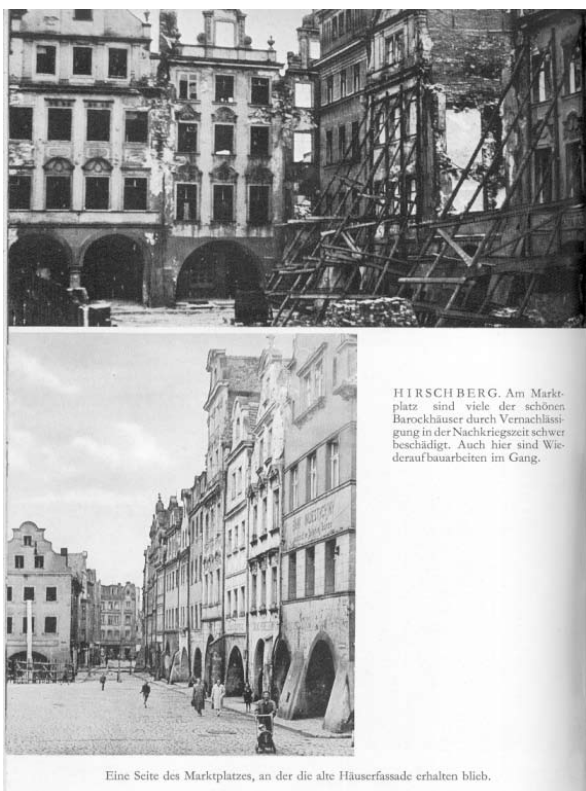
Zdjęcia Wassermanna zniszczonych kamienic na jeleniogórskim rynku. Podpis mówi o zaniedbaniach powojennych i trwającej odbudowie, aczkolwiek w tekście omyłkowo przypisuje ten stan ostrzałowi podczas wojny
