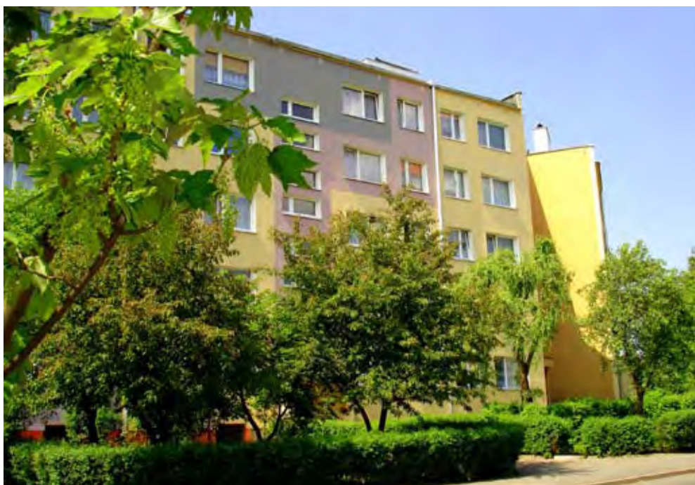
Budynek przy ul. J. Elsnera 8 ocieplony w 2006 r. – maj 2007 r. (fot. Grażyna Tęcza)
