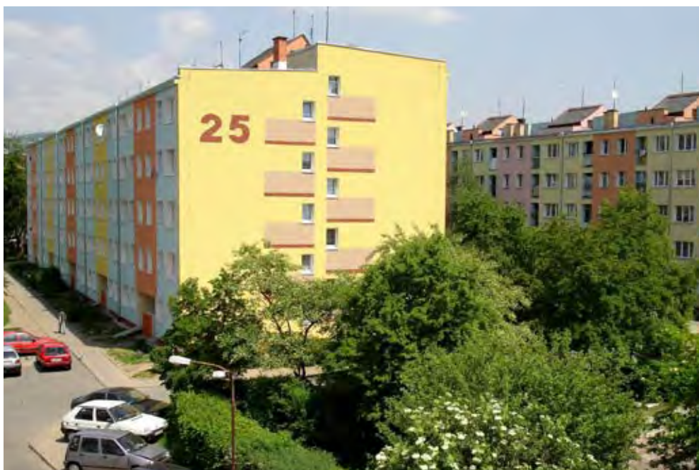
Budynki przy ul. L. Różyckiego 25 i 27 ocieplone w latach (odpowiednio) 2006 i 2005 – maj 2007 r. (fot. Grażyna Tęcza)
