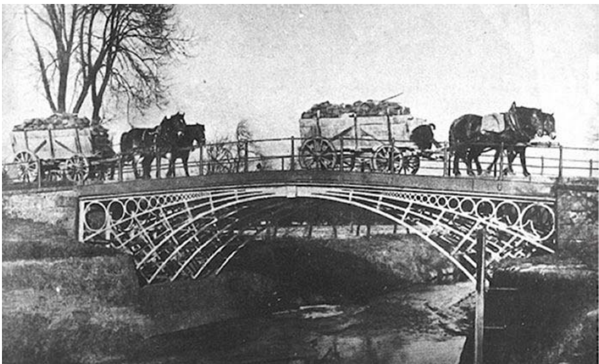
Die erste Gußeiserne Brücke auf dem europäischen Kontinent auf der Kohlenstrasse in Laasan bei Schweidnitz/Niederschlesien (1796)
