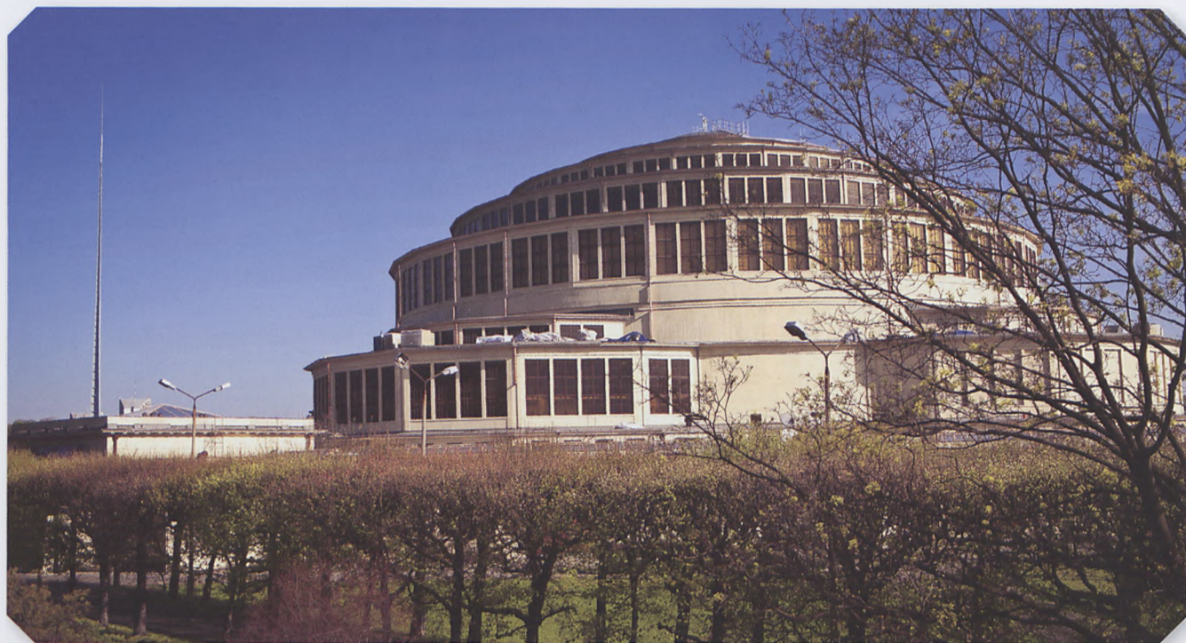
Hala Stulecia • Jahrhunderthalle • Centennial Hall
