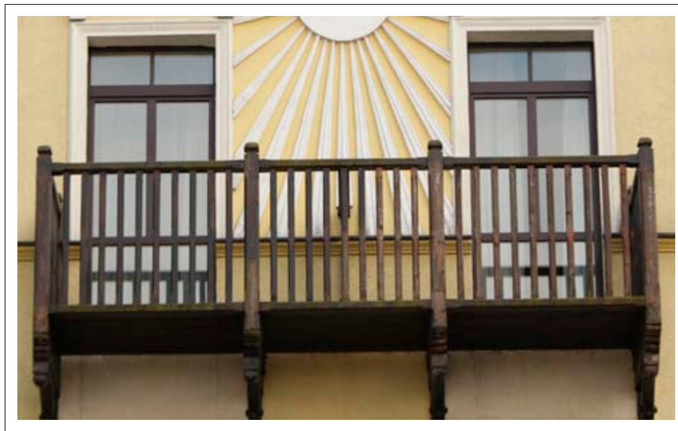
Balkon w elewacji frontowej
