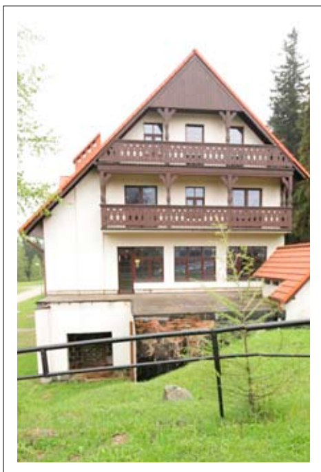
Elewacja boczna z podwójną kondygnacją balkonów
