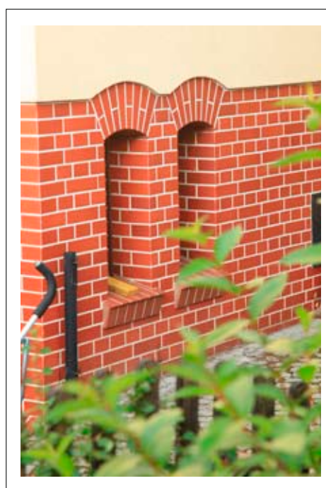
Bliźniacze okna piwnicy
