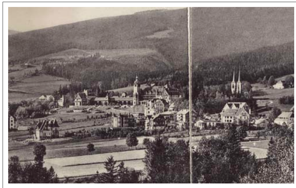
Widok zespołu z przeciwnego stoku – zdjęcie archiwalne
