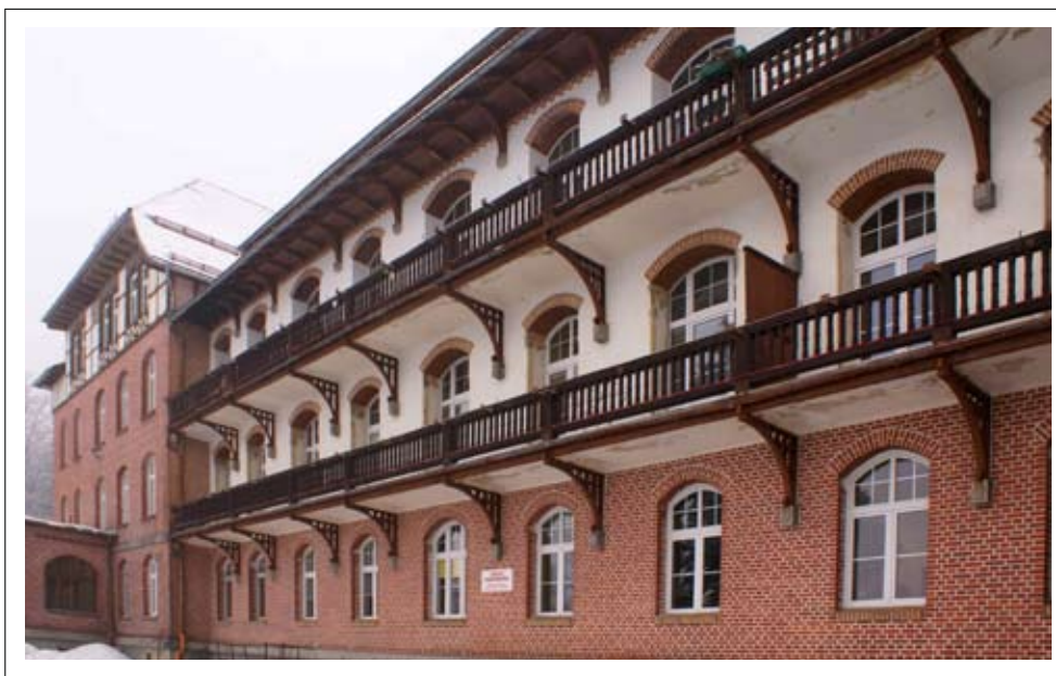
Balkony na elewacji tylnej
