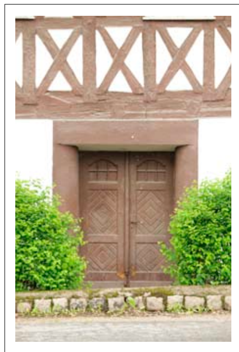
Portal ze stolarką drzwiową
