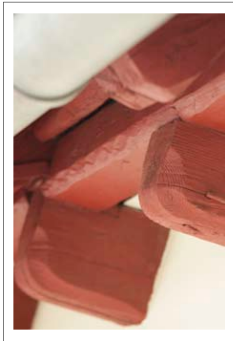
Fragment wsporników dachowych
