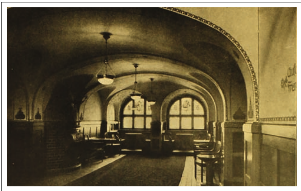
Wnętrze – zdjęcie archiwalne
