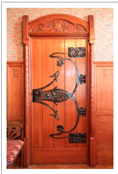
Stolarka drzwiowa z metaloplastycznymi, secesyjnymi okuciami.
