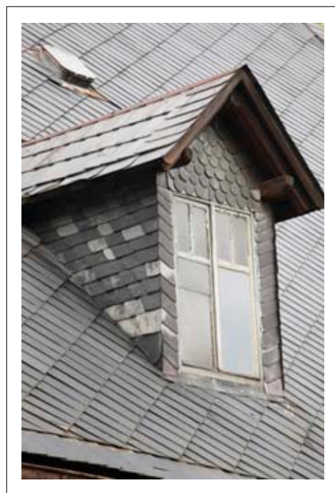
Szczyt opierzony łuską wykonaną z balaitowego łupka
