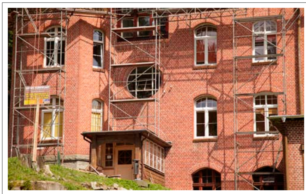
Licowanie elewacji cegłą klinkierową
