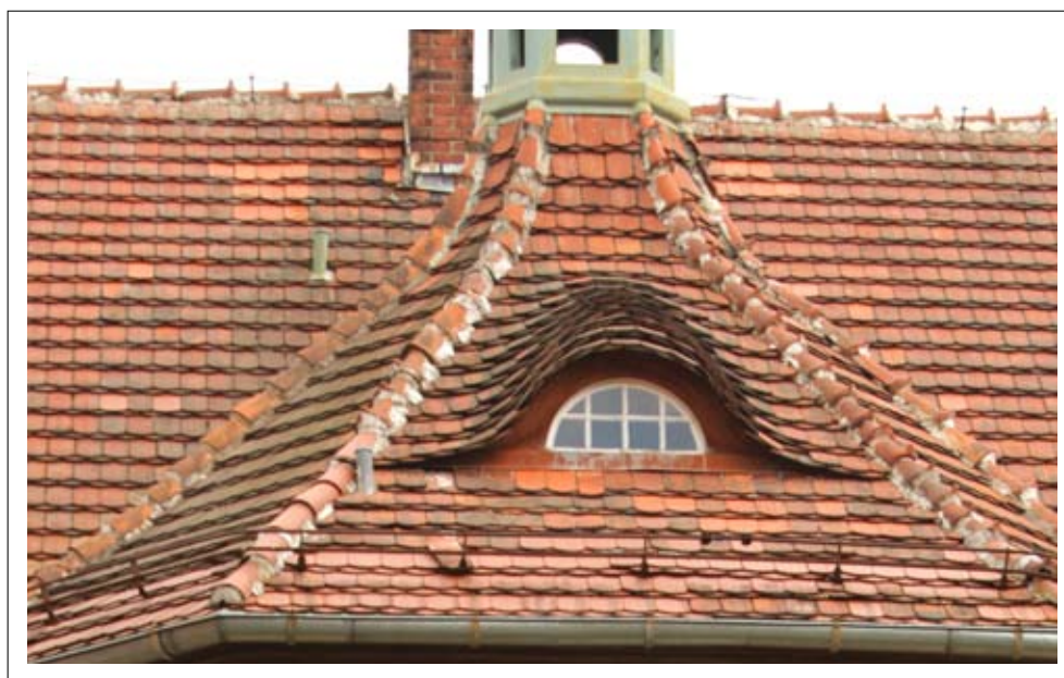
Detal - pokrycia dachowego
