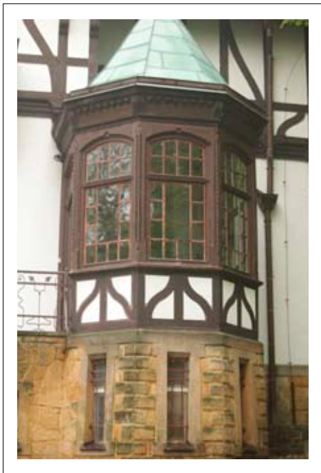
Ryzalit werandy w elewacji zachodniej z konstrukcją ryglową
