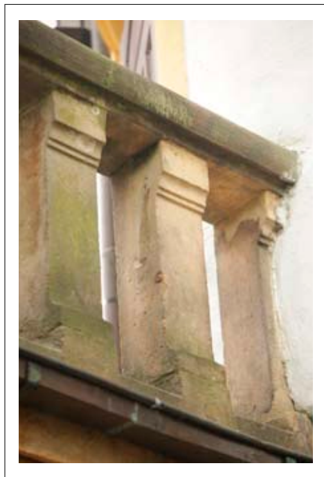
Kamienne tralki balustrady
