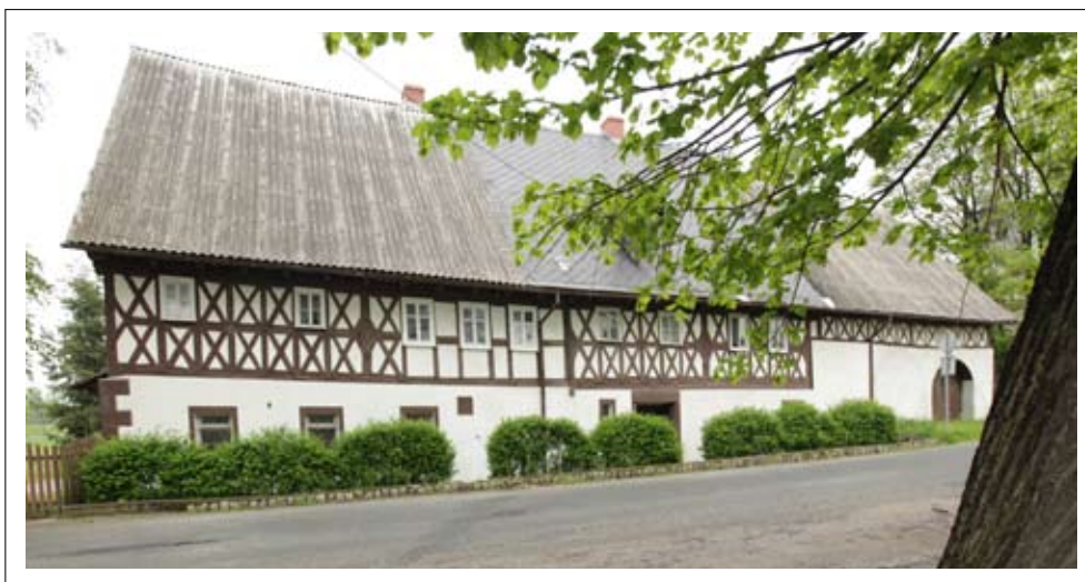
Widok elewacji frontowej
