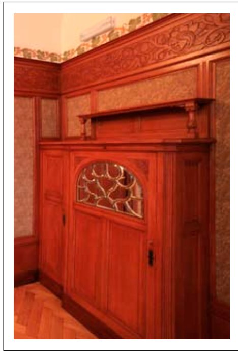
Boazeria drewniana z wbudowanymi elementamiumeblowania
