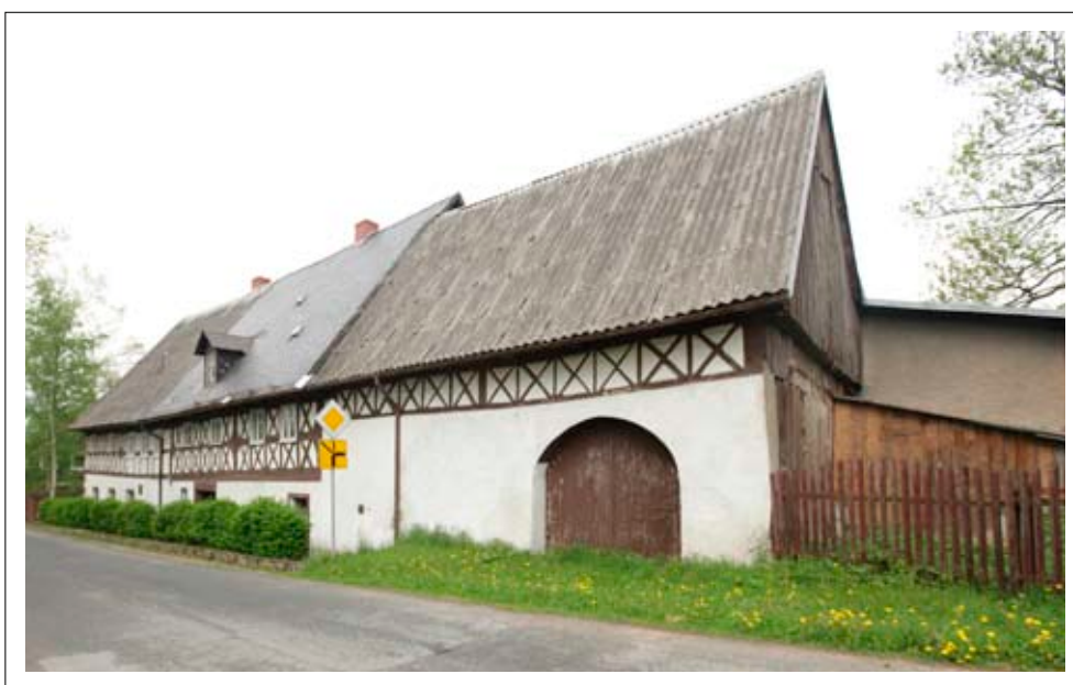
Część gospodarcza budynku wraz z bramą przejazdową w elewacji frontowej
