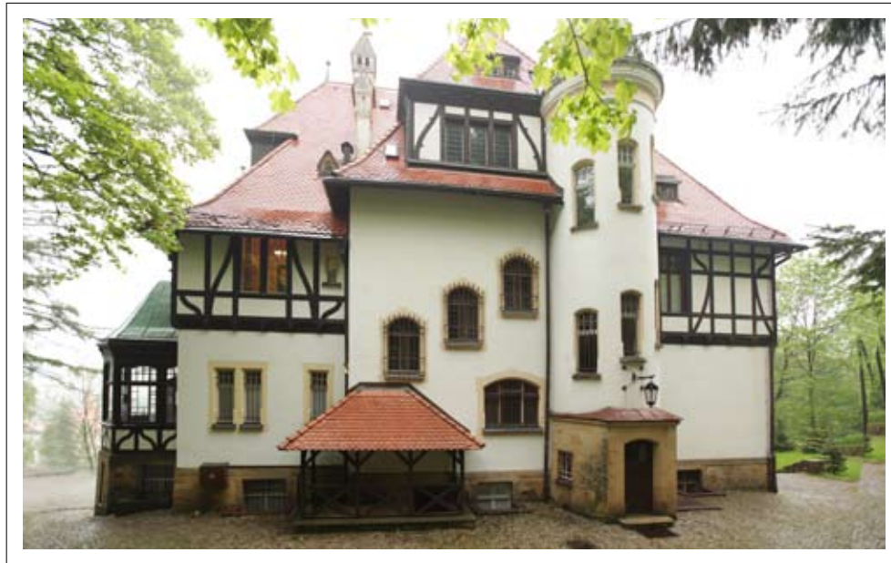
Widok elewacji południowej
