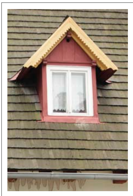
Facjatka dachowa – pokrycie gontowe
