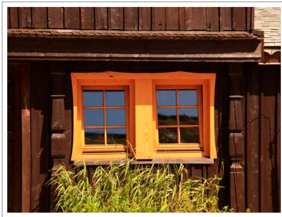
Zdjęcia elewacji z detalem drewnianych słupów
