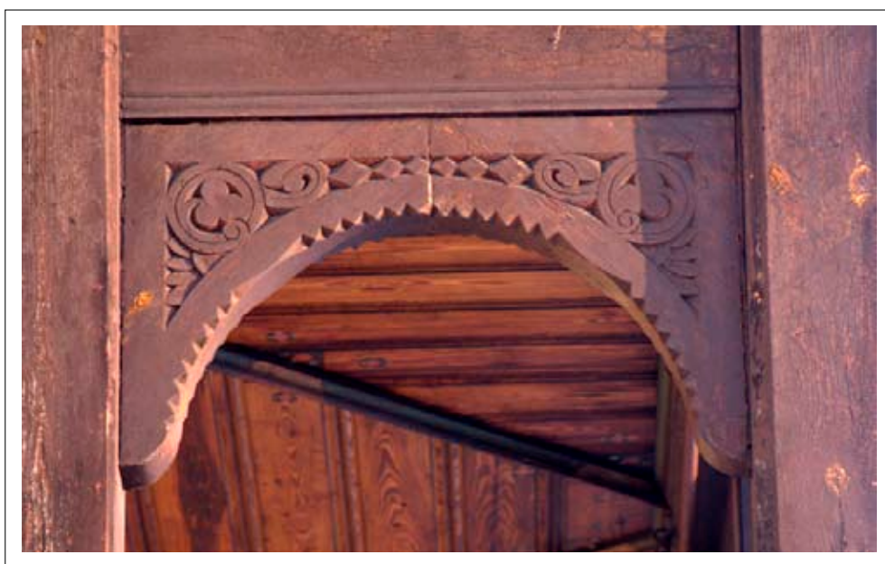
Szpital Wysoka Łąka w Kowarach – motyw snycerki drewnianej - obudowa balkonu
