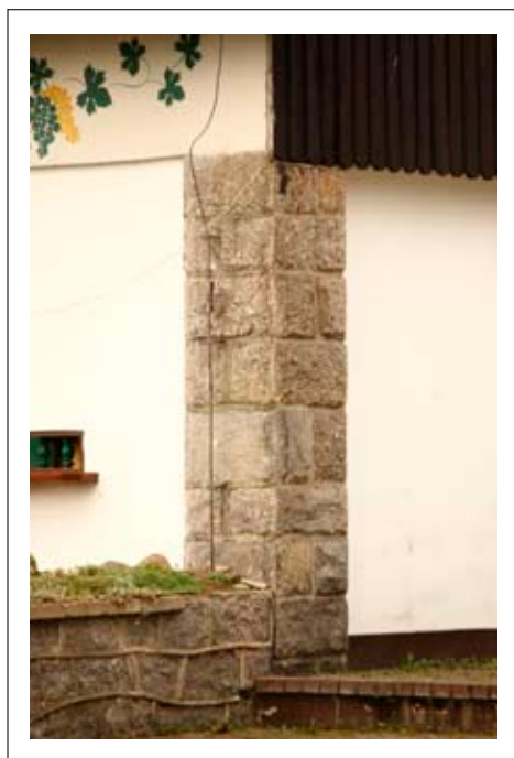
Detal elewacji – pilastry obudowane w granicie
