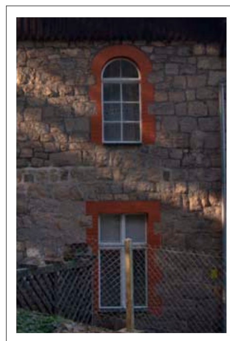
Budynek towarzyszący – konstrukcja murowana elewacja granitowa
