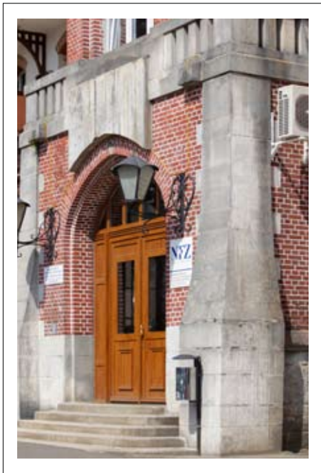
Detal elewacji – kamieniarka piaskowiec
