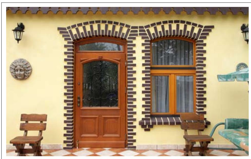
Obudowa okna wykonana przy użyciu cegły klinkierowej
