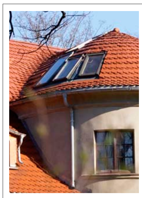
Budynek dawnego przedszkola przy ul. Cervi w Cieplicach – doświetlenie oknami połaciowymi
