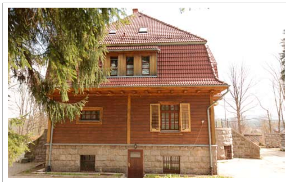
Elewacja boczna – okno z okiennicą
