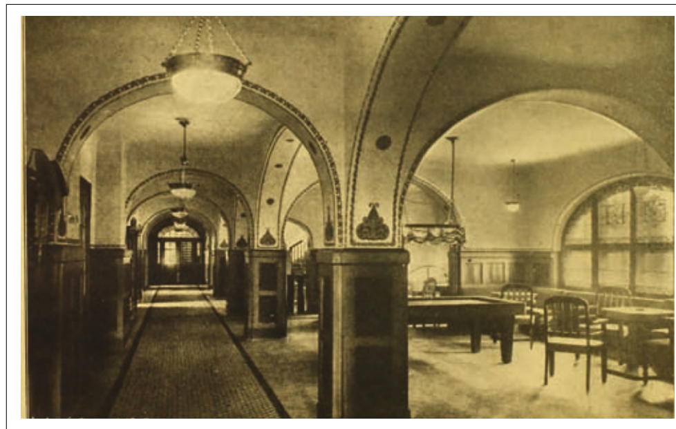
Wnętrze – zdjęcie archiwalne
