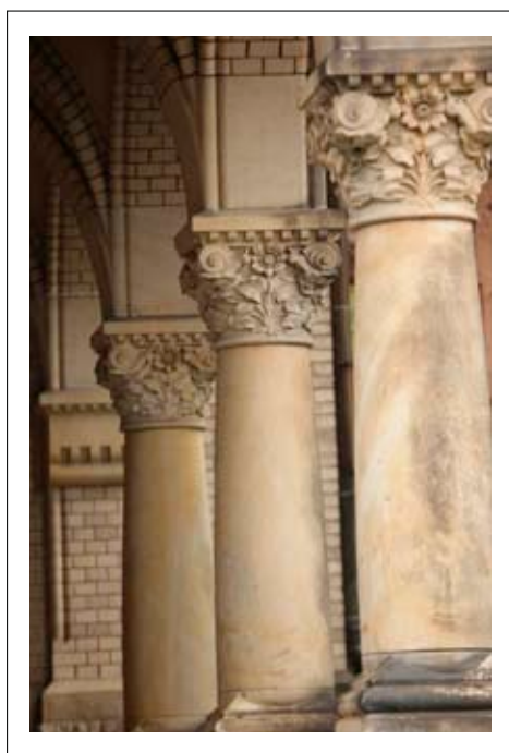
Kolumny podcienia w elewacji zachodniej
