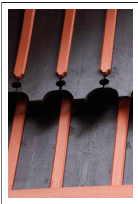
Detal - elementy ozdobne ciesielskie, dolne zakończenia desek elewacji
