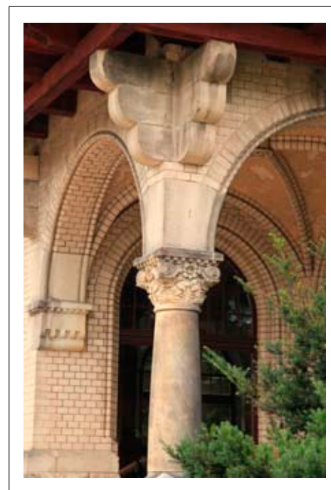
Krokwiny podtrzymujące balkon nad podcieniem arkadowym
