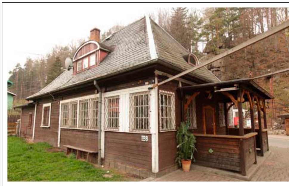
Widok od strony ulicy
