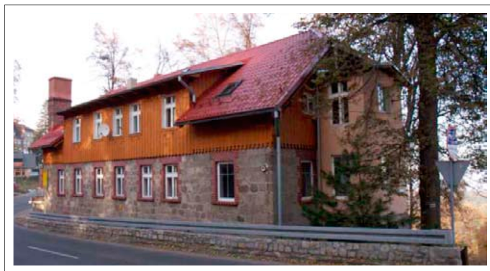
Budynek pensjonatowy w Karpaczu – elewacja wykonana z kamienia granitowego, opaski okienne z cegły klinkierowej, deskowanie w górnej części
