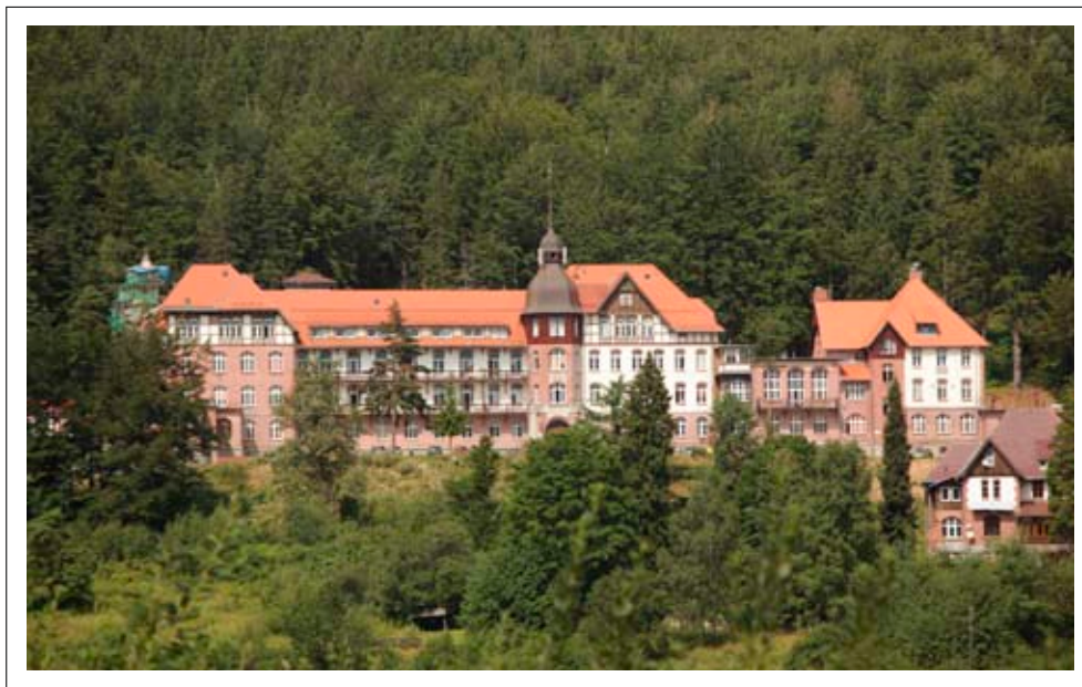
Szpital Kolejowy – widok ogólny
