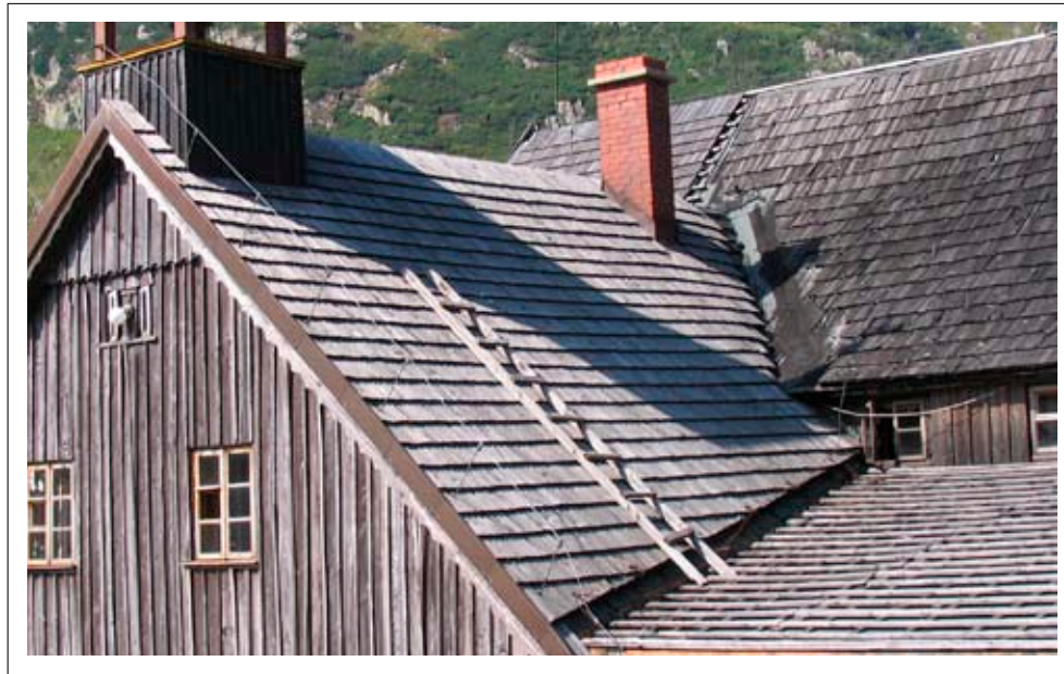
Schronisko Samotnia w Karpaczu – pokrycie dachowe- gont bitumiczny, pierwotnie gont drewniany
