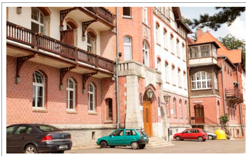
Elewacja frontowa – modernistyczne wsporniki pod tarasami
