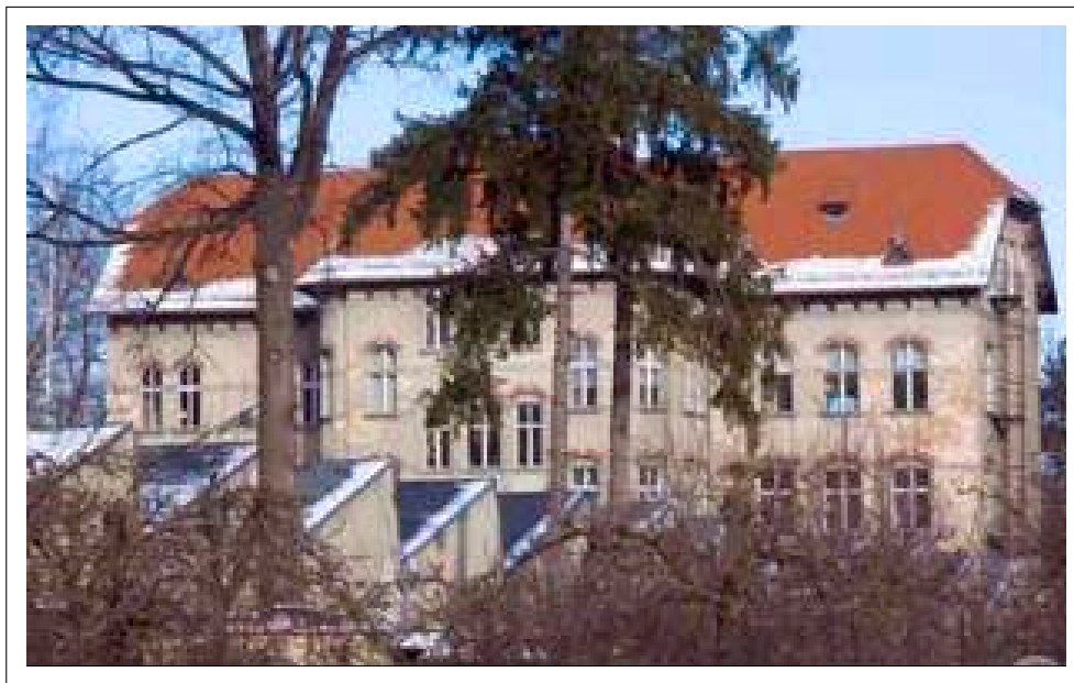
Współczesny widok na tylną elewację budynku szkoły i dobudowane i połączone ze szkołą budynki warsztatów szkolnych o formach architektonicznych zupełnie nie powiązanych z budynkiem historycznym.
