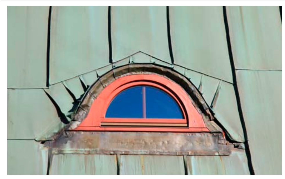
Detal – „wół oko” w połaci dachowej
