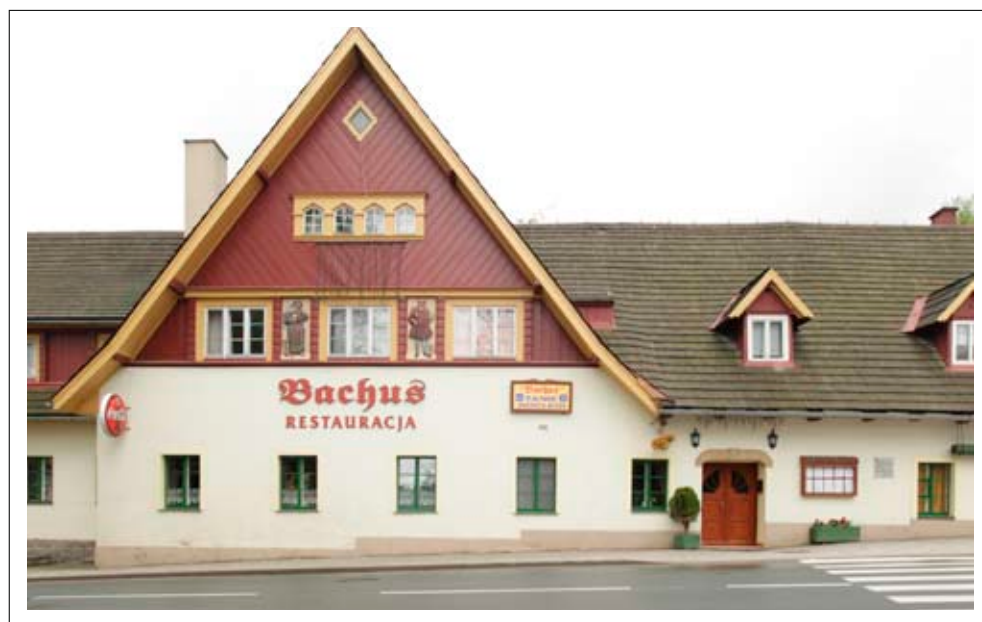
Fragment elewacji z widokiem szczytu
