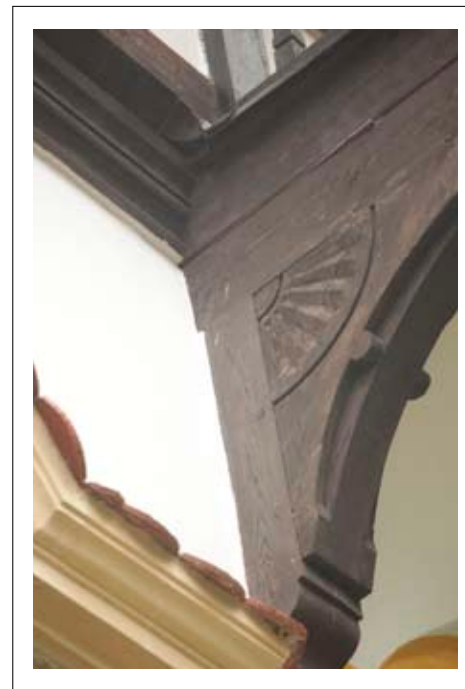
Snycersko opracowany detal drewnianych loggii
