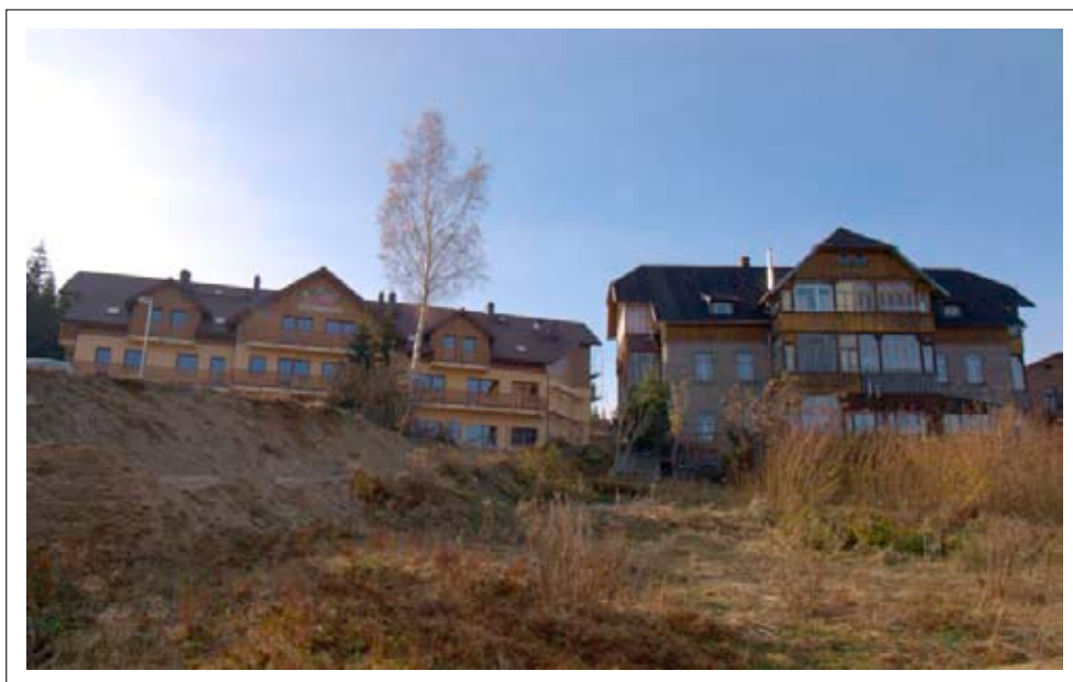
Karpacz, budowa nowego obiektu obok dawnego schroniska „Ratowników Górskich”
