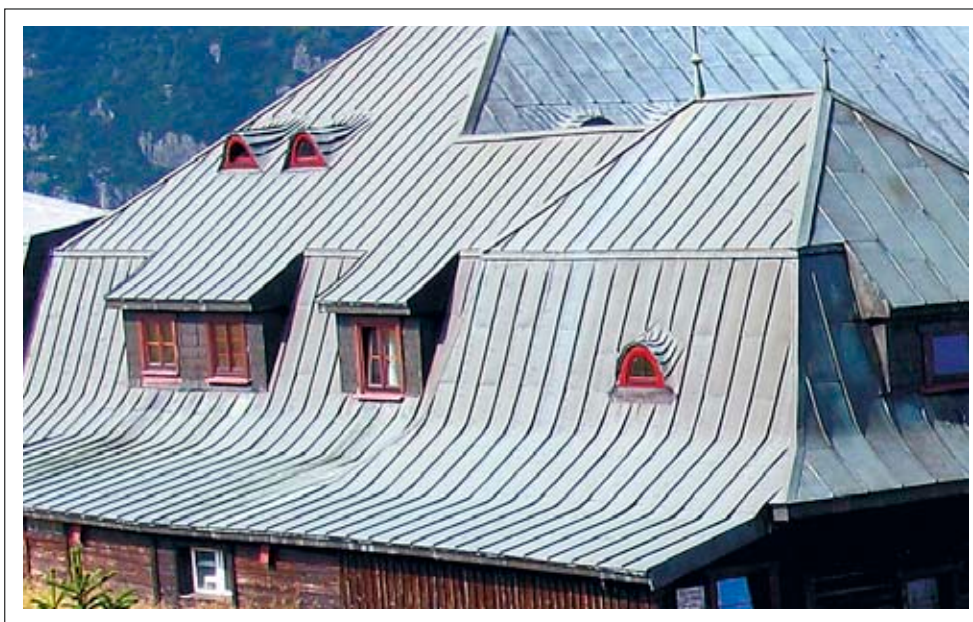
Schronisko Strzecha Akademicka w Karpaczu – pokrycie dachowe- blacha w rąbek
