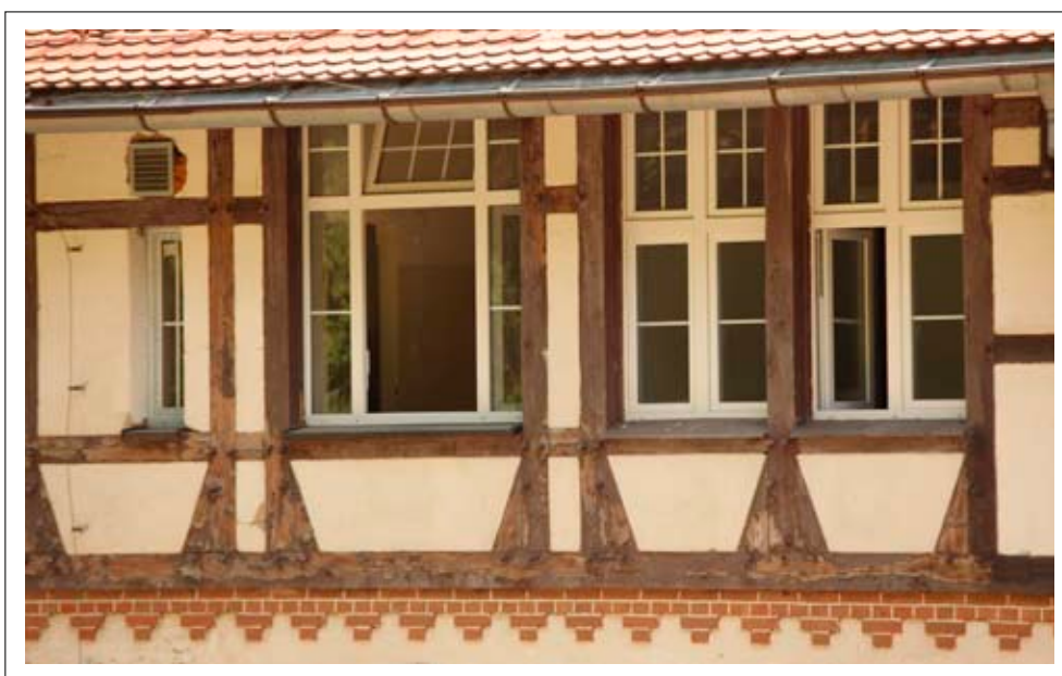
Fragment ściany o konstrukcji szkieletowej
