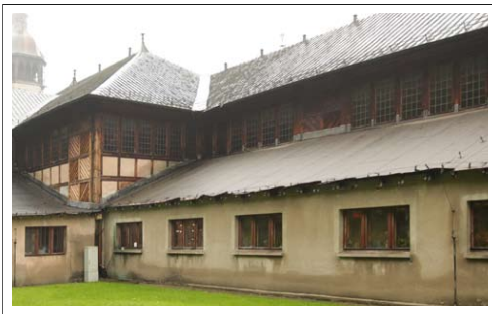
Uzdrowisko Świeradów Zdrój – Hala Spacerowa, elewacja tylna przybudówki
