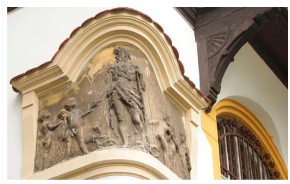
Kamienny relief w narożniku elewacji północnej i zachodniej
