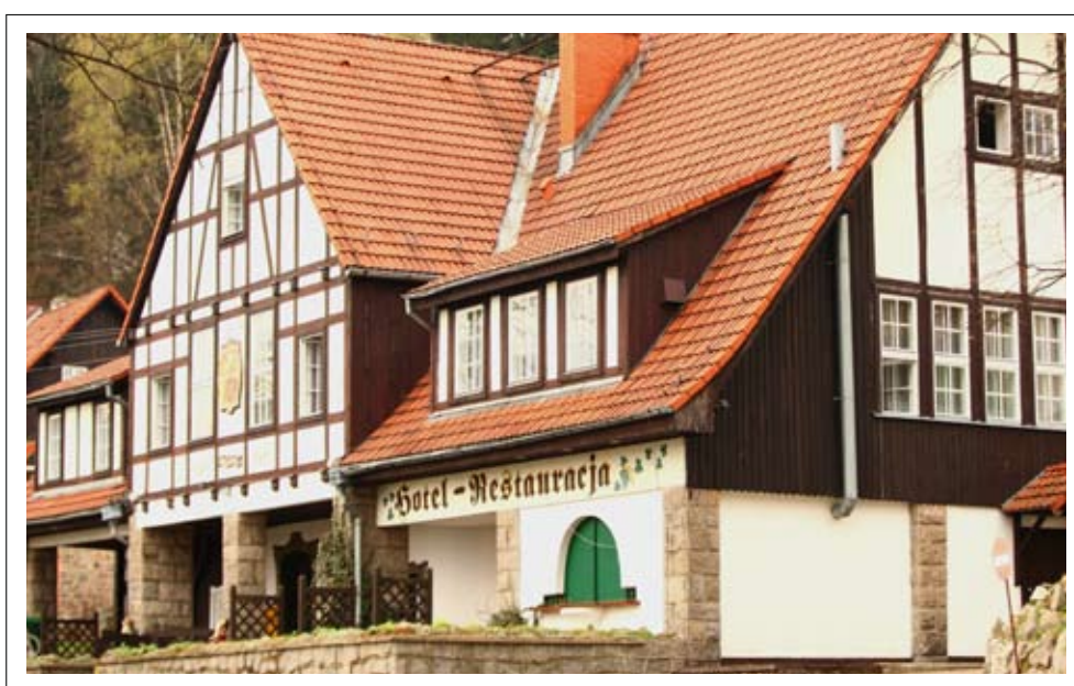
Gospoda z hotelem Krasnoludki - elewacja – konstrukcja ryglowa
