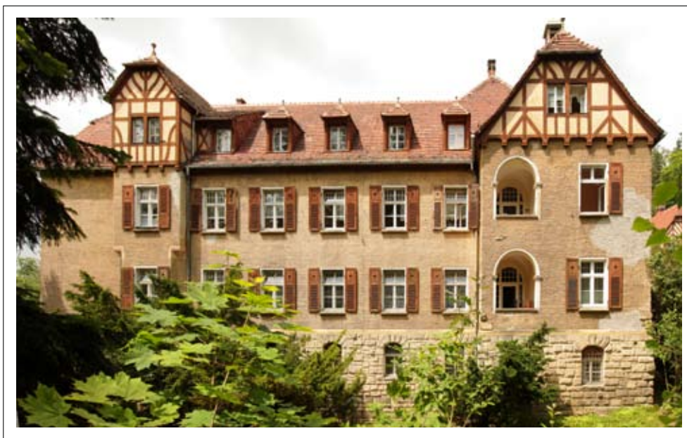
Elewacja boczna – skrzydło prawe
