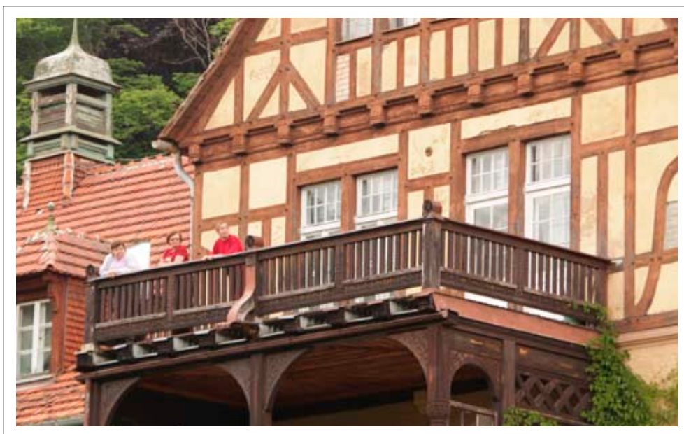
Detal - drewniane balustrady balkonów
