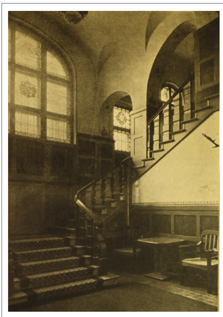
Wnętrze – zdjęcie archiwalne
