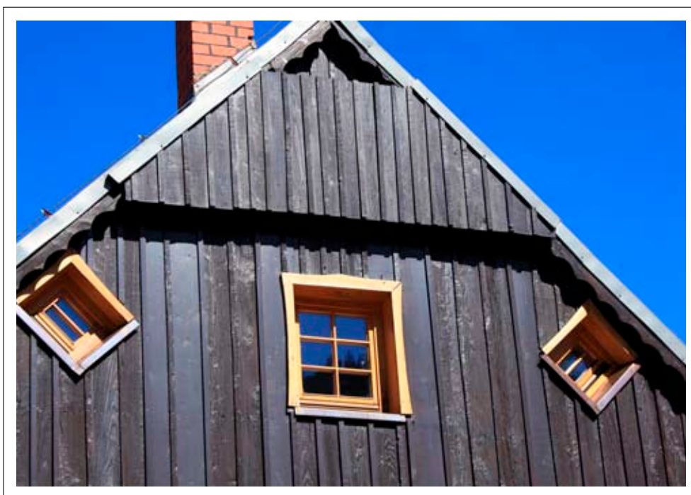
Odeskowanie szczytu z oknami o różnym kącie ustawienia
