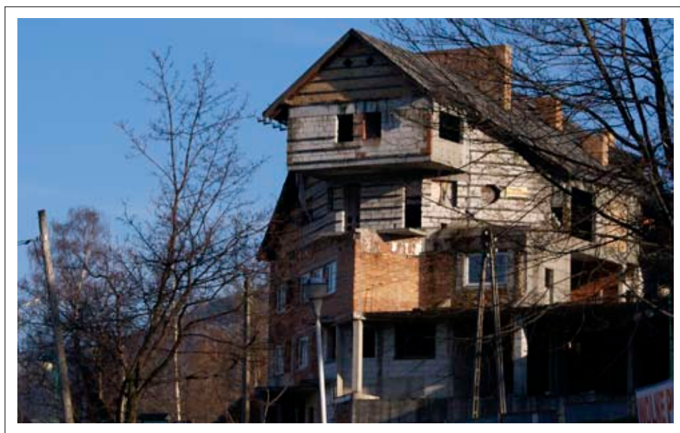
Nieukończona budowa hotelu w Karpaczu
