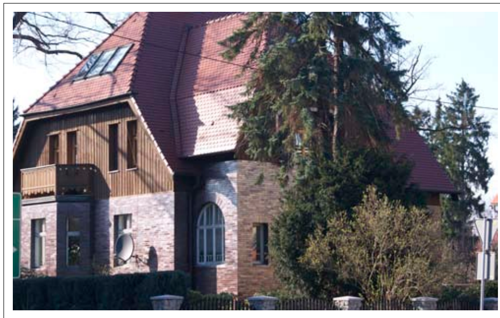
Zastąpienie tynku cegłą klinkierową w Jeleniej Górze – Cieplicach, z likwidacją detalu architektonicznego spowodowało, że secesyjny budynek stał się zbyt przytłaczający.
