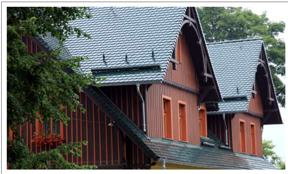
Lukarny w elewacji bocznej
