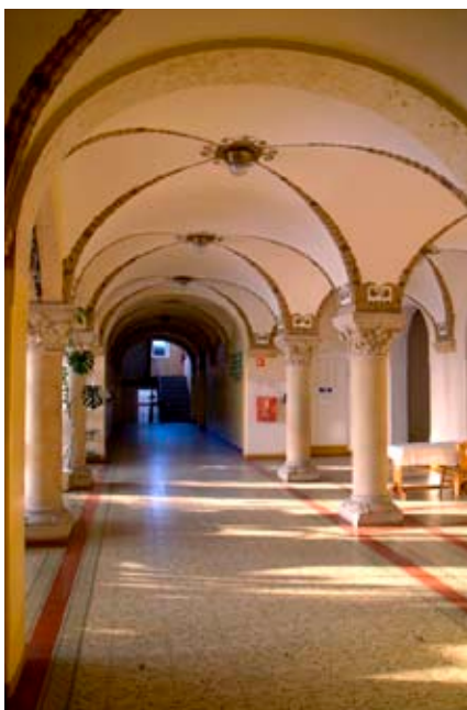
Widok wnętrza obiektu – korytarz obudowany z dwoma rzędami kolumn (il. nr 39)
