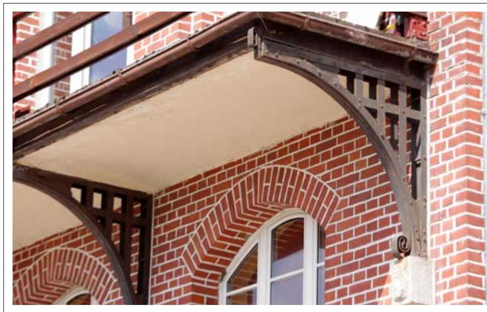
Detal wsporników pod balkonami
