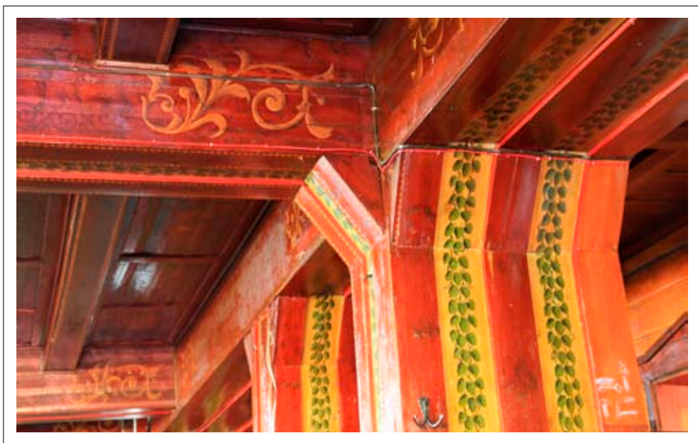
Zdobienia rustykalne na słupach i belkach stropowych o motywach roślinnych
