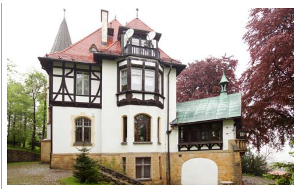
Widok elewacji wschodniej
