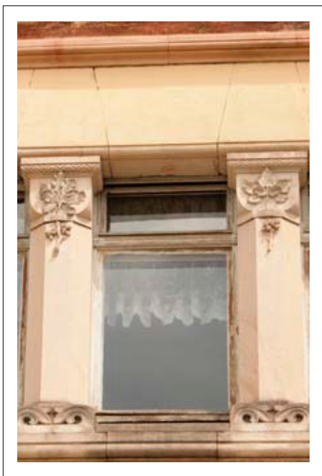
Pilastry okalające okna
