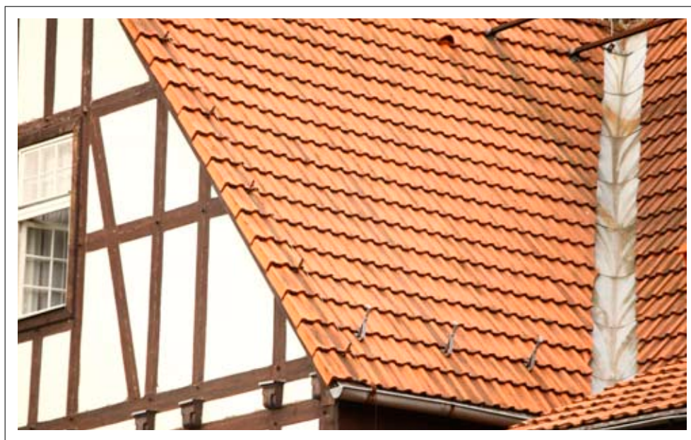
Gospoda z hotelem Krasnoludki - pokrycie dachowe- dachówka ceramiczna
