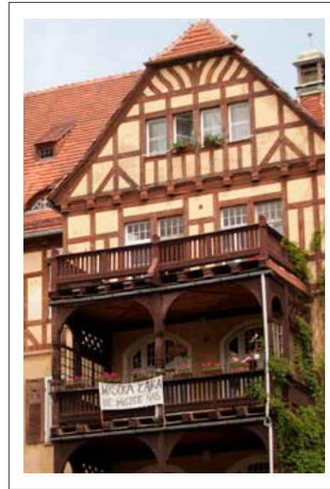
Detal – balkon drewniany
