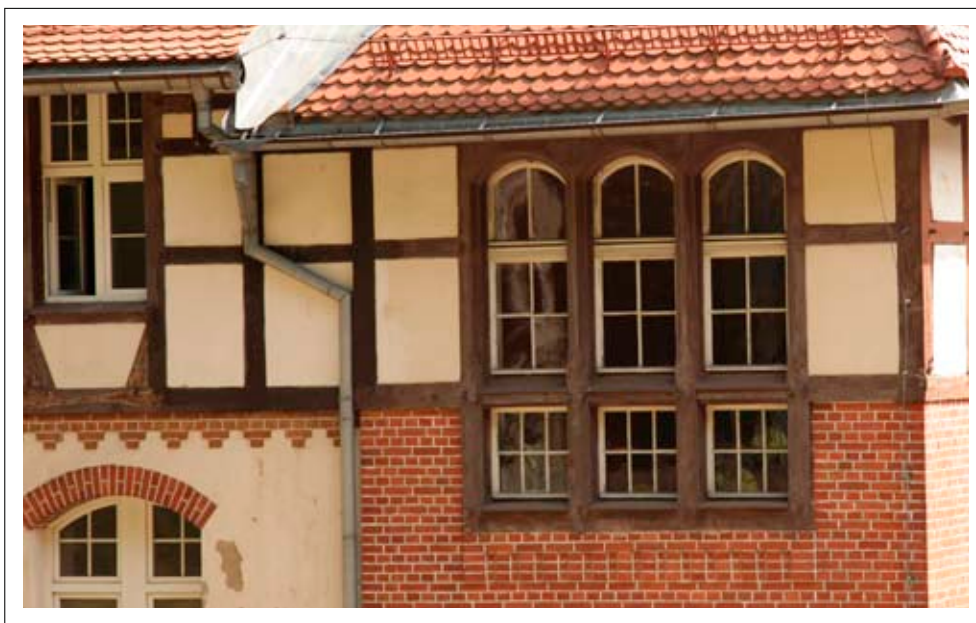
Fragment ściany o konstrukcji szkieletowej
