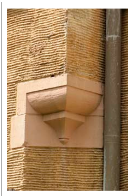
Detal – kamieniarka z piaskowca zdobiąca narożnik budynku
