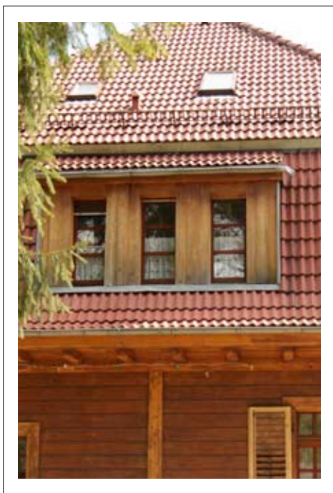
Fragment z facjatką dachową
