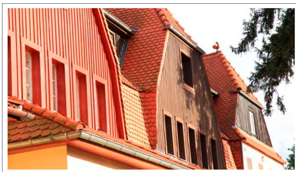
Dachy i szczyty budynków od nr 8-12
