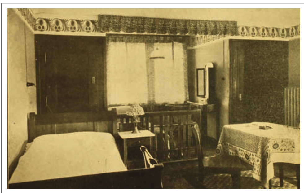
Wnętrze – zdjęcie archiwalne
