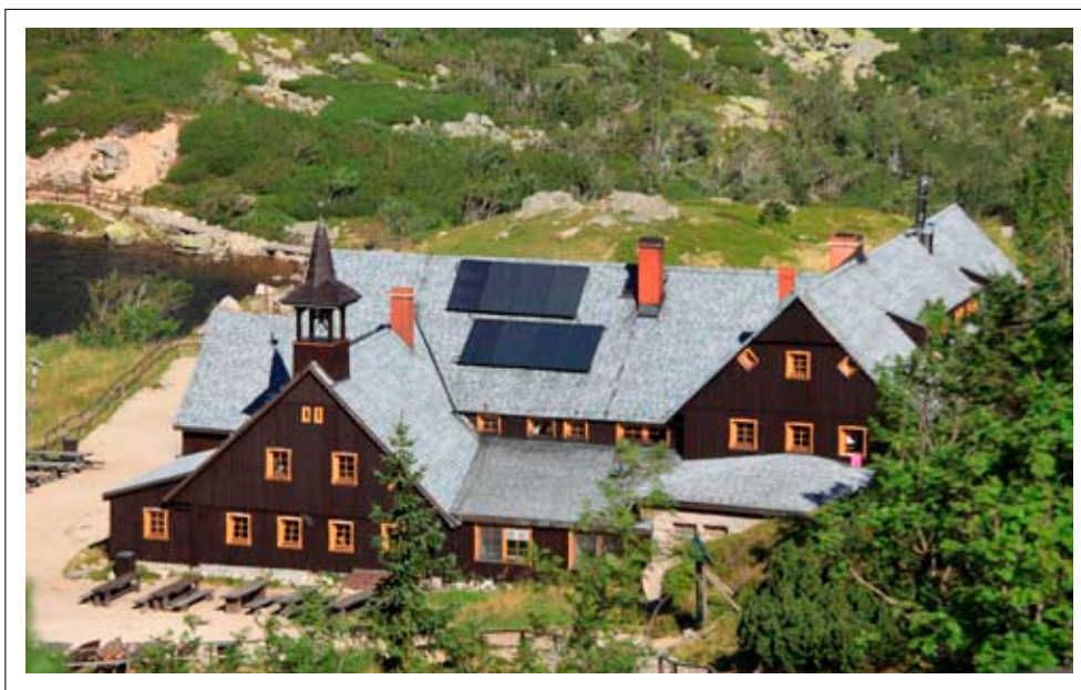
Współczesny widok z perspektywy ptasiej z widocznymi kolektorami słonecznymi
