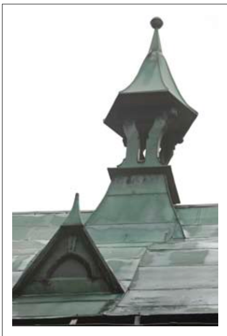
Światliki dachowe i sygnaturka
