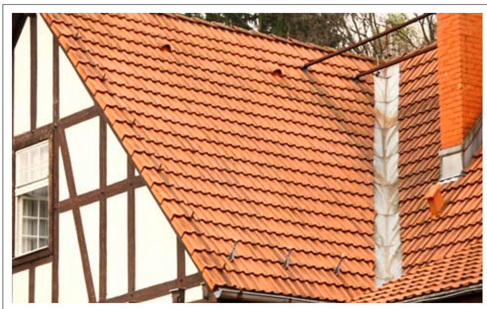
Detal pokrycia dachowego – dachówka ceramiczna
