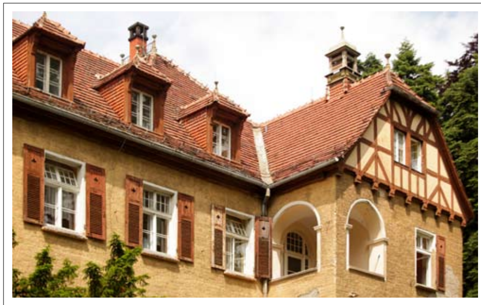
Elewacja boczna- skrzydło prawe
