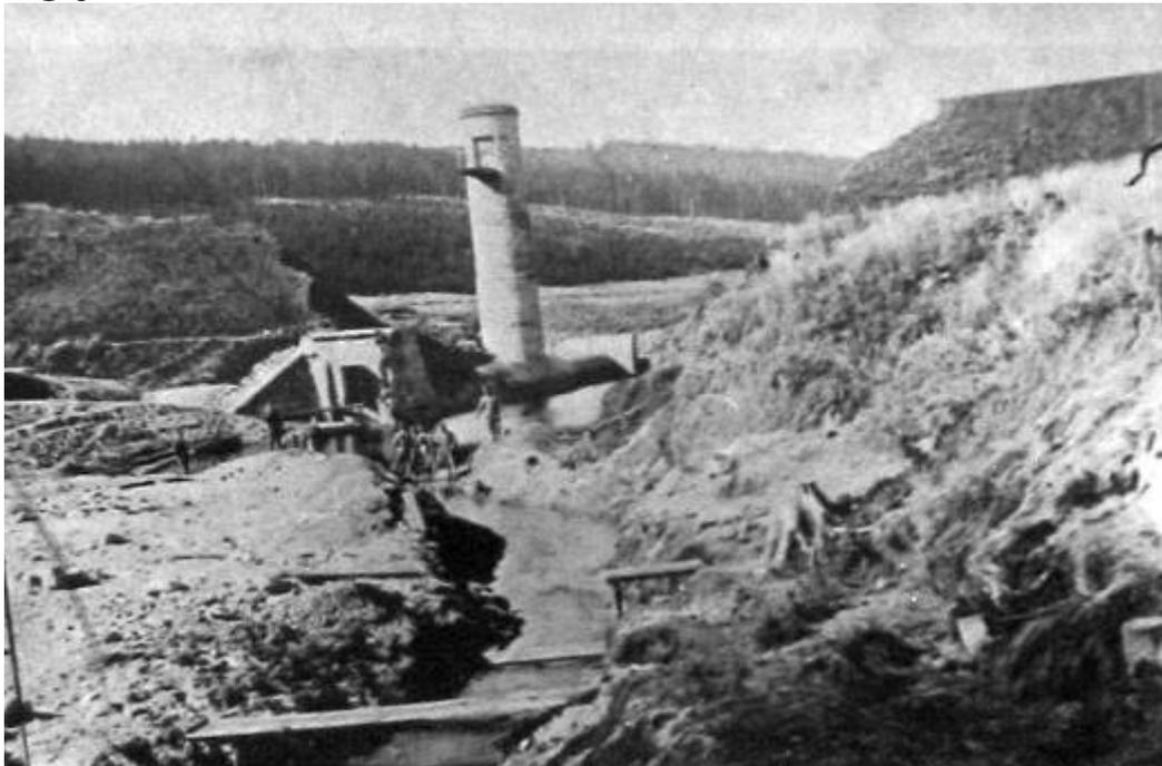
Dammdurchbruch der Talsperre der Weißen Desse, 18. September 1916, 5 Uhr nachmittags. Die Talsperre an der Weißen Desse war als Erddamm ausgeführt. Sie lag auf der Sohle Seehöhe 806,34 m. Die Dammhöhe auf Seehöhe 820,50 m und hatte von der Sohle ein Höhe von 14,16 m.
