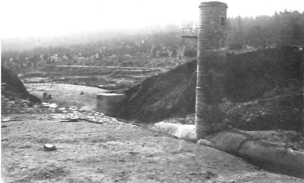
Zur Abdichtung des Grundes war an der Wasserseite des Dammes bis über 4 m unter Terrain ein 3 m breiter Lehmkern eingestampft und in den lehmigen Untergrund eine Spundwand eingetrieben, das Schüttungsmaterial wurde aus dem Staubecken gewonnen, in Schichten von 40 cm aufgeschüttet und jede solche Schüttung mittelst einer 3000 kg schweren Walze auf 30 cm Dicke zusammengepresst. In der Mitte des Dammes befindet sich der Grundablaßstollen
