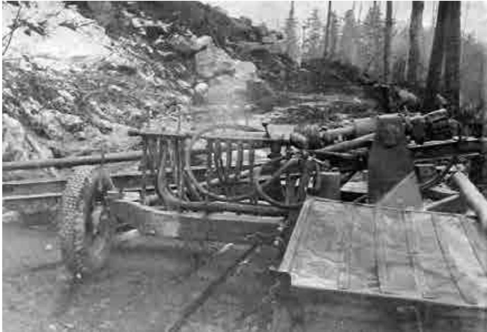
Bohrmaschinen am Werke. Für eine Sprengung mußten 30 – 35 m tiefe Löcher in den oberen Straßenrand gebohrt werden. Der Bau über den Hüttenberg wurde eingestellt und nach dem zweiten Projekt über Neustück geführt. Nachher mußte aber die
