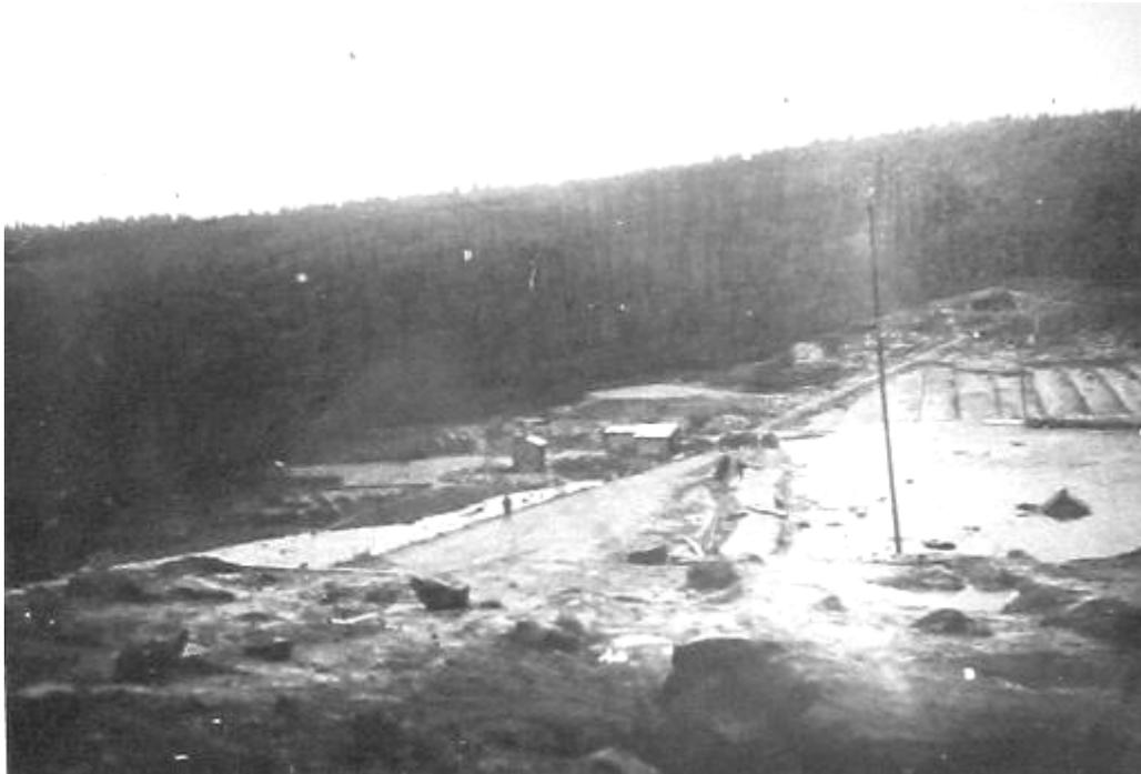
Das Wasser durchgelassen der Talsperre Darre von dem Wolkenbruch am 17. August 1913 und hier abgelassene Talsperre, ein Teil des Dammes ist weggeschwemmt.
