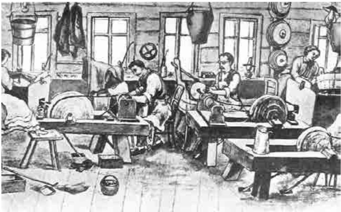
Das Bild zeigt das Innere der Schleifstube im 19. Jahrhundert, 2 Frauen bei der Kastenarbeit (waagrecht drehende Steine, Eisenscheiben oder hölzerne Polierscheiben), 2 Männer bei der Schlegelararbeit (senkrecht rotierende Steine). Die Drehkraft wurde von der Welle des Wasserrades durch Treibriemen auf
