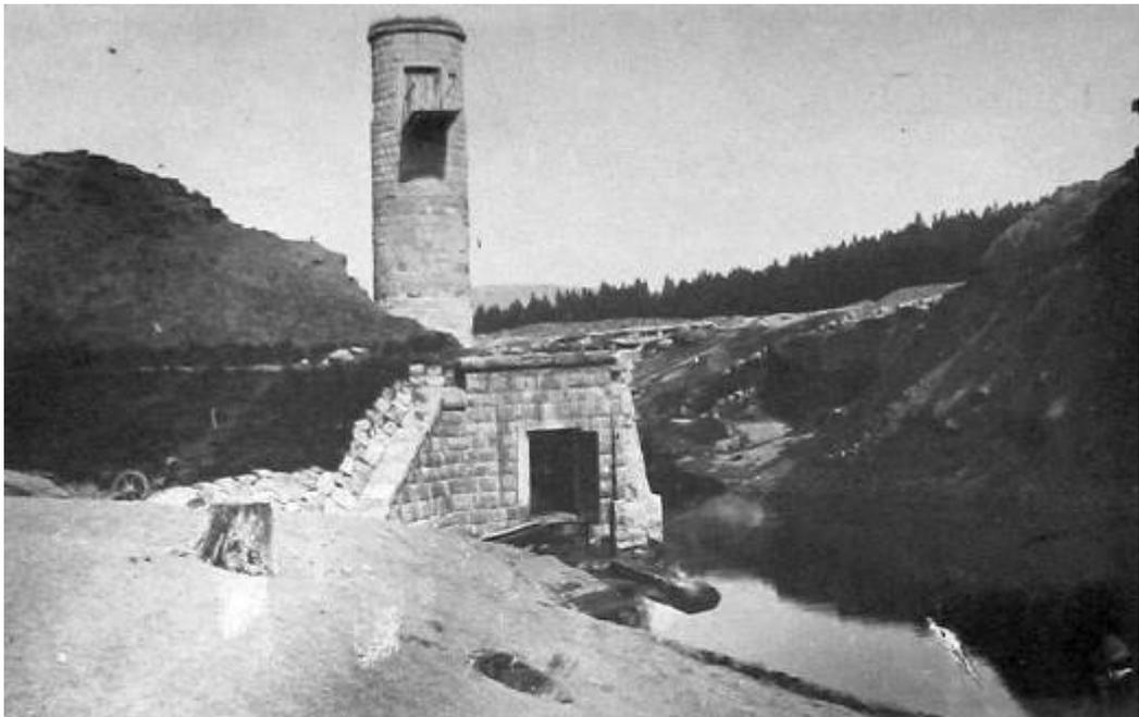
Am wasserseitigen Ende des Stollens war ein 2 ½ m langer Pfropfen aus Klinkermauerwerk zur wasserdichten Abschließung eingebaut.
