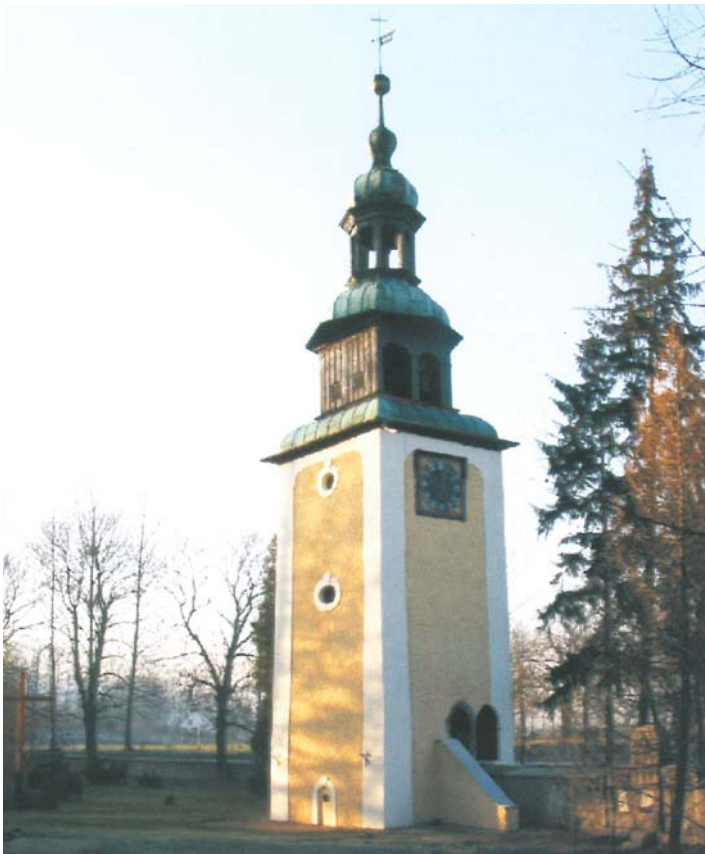
Kirchturm mit heutigem Aufgang. Ursprünglich musste man mit einer Leiter in den Turm
