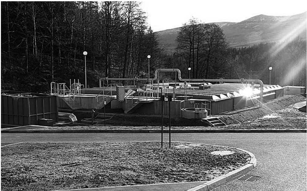
Oczyszczalnia Ścieków Szklarska Poręba, fot. Archiwum KSWiK
