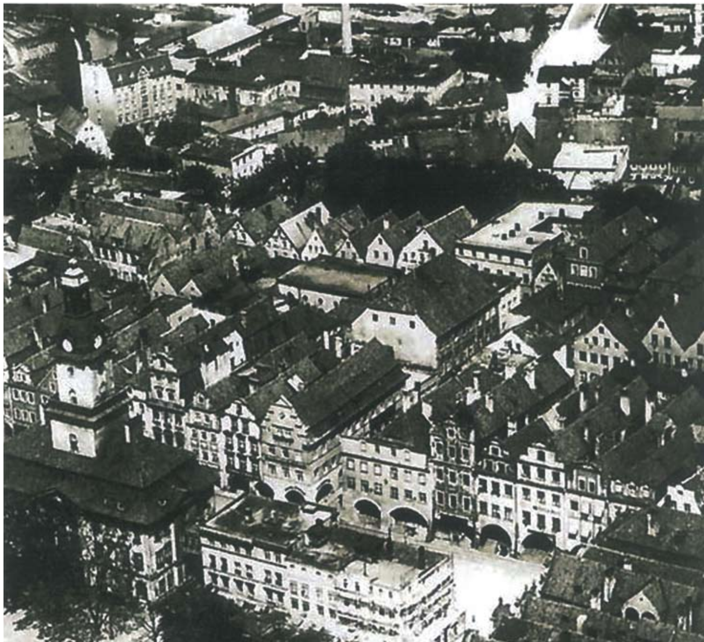
W centrum zdjęcia – obiekt z płaskim dachem – jeleniogórska synagoga.
