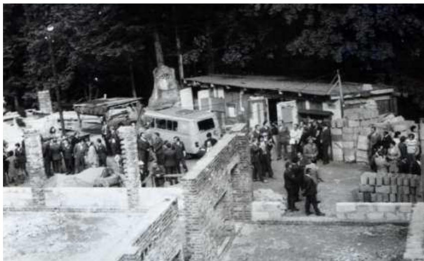
Teren budowy i skala robót, które należało wykonać.
