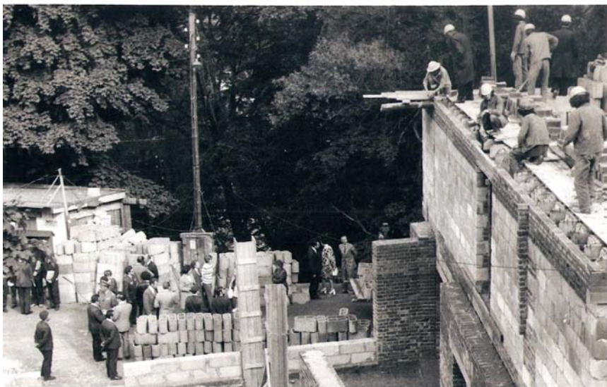
Goście, przyglądają się pracy na budowie...
